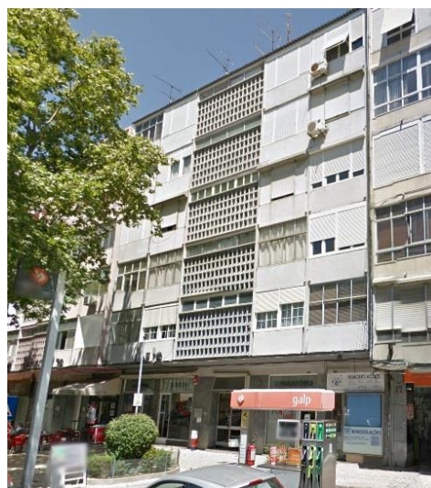
Fig. 83 – Planta e imagem da fachada frontal vista da rua.
