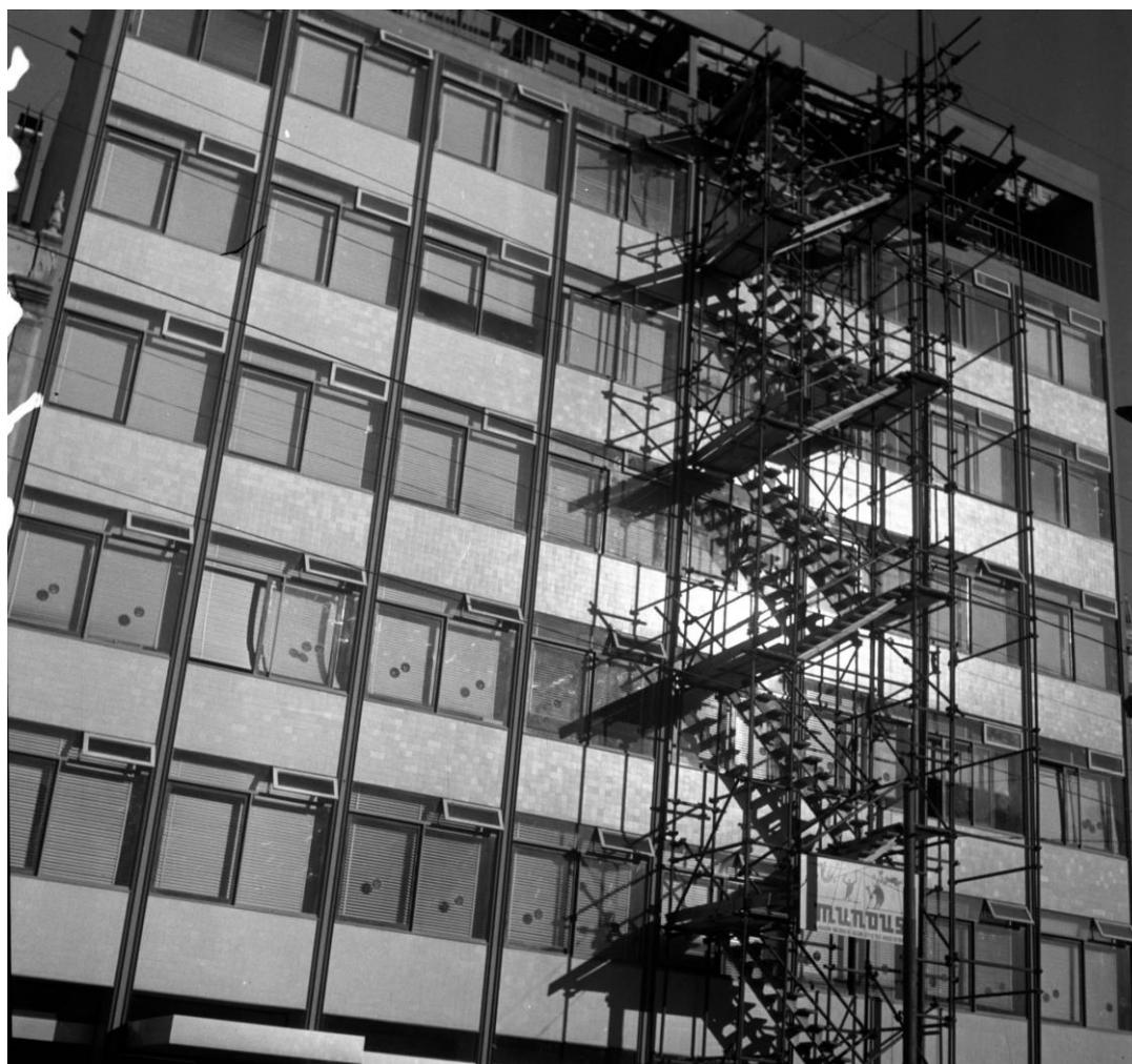
Fig. 86 – Planta e imagem da fachada frontal vista da rua.
