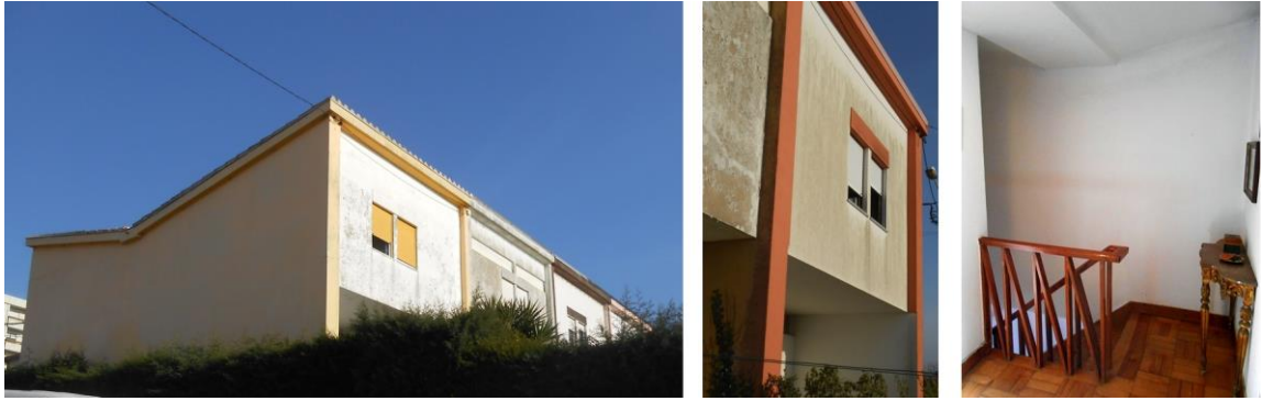
Fig. 52 - Composição de fotos da unidade T4: Vista do bloco lateral, do espaço que antecede a entrada e do corredor do andar superior, próximo à escada.
