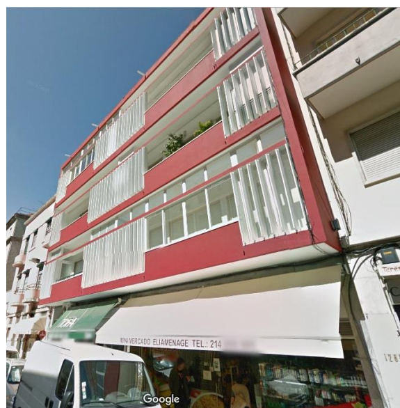
Fig. 81 – Planta e imagem da fachada frontal vista da rua.
