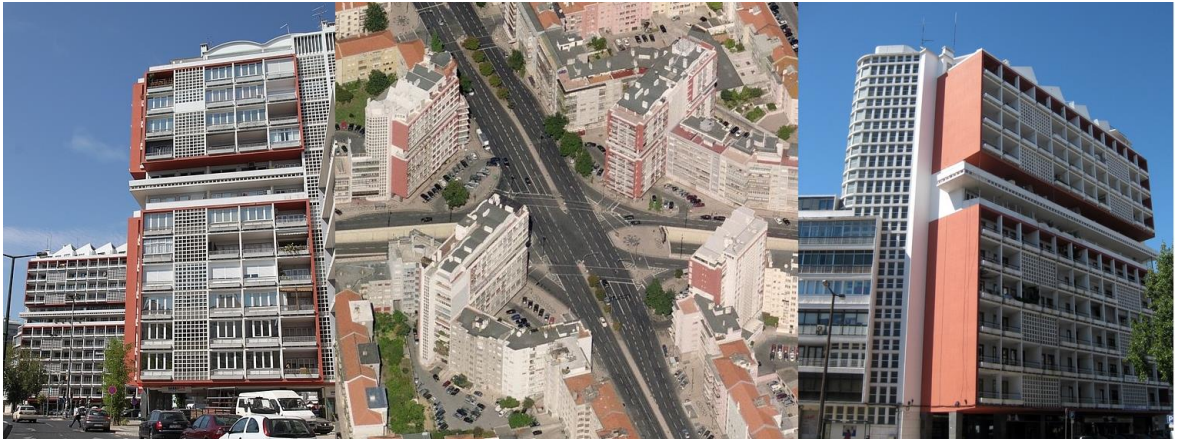
Fig. 21 – Composição de fotos dos edifícios no cruzamento das Avenidas de Roma e dos EUA.
