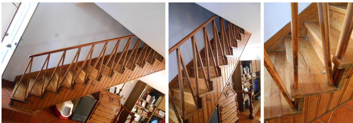
Fig. 67 – Composição de fotos da escada da unidade T4.
