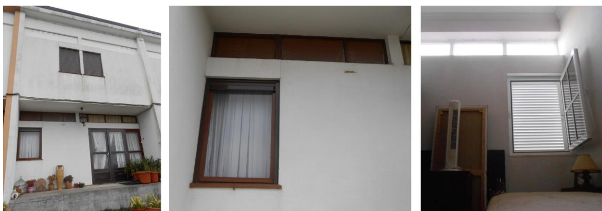
Fig. 68 – Composição de fotos com destaque na primeira fotos para as 3 folhas da porta da entrada principal, e as janelas dos quartos e ventilação à direita.
