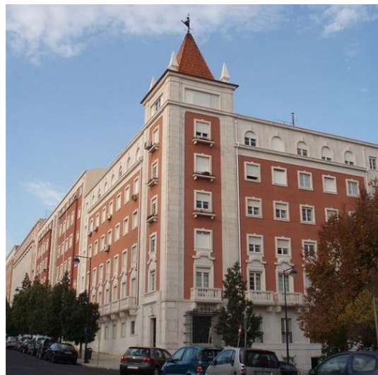
Fig. 18 – Edifício na Avenida de Sidónio Pais, 16, Lisboa. Exemplar construído em 1947, de Pardal Monteiro, constitui-se num exemplo do estilo arquitectónico oficial do Estado Novo, chamado de “ Português Suave”.
