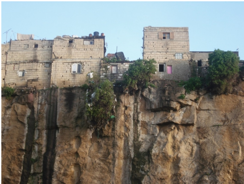
Fig.14 - Pormenor dos edifícios de habitação precária construídos em zona de risco (fonte: Bellmunt Architectes)
