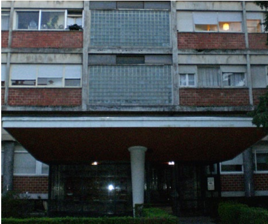
Figs. 28, 29. Viana de Lima. Edifício de habitação. 1953. Rua de Costa Cabral, 750. Porto.
