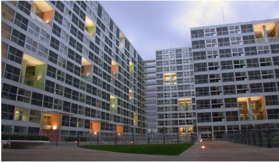
Figs. 55, 56, 57, 58. Vistas exteriores e vistas interiores dos f-rooms .
