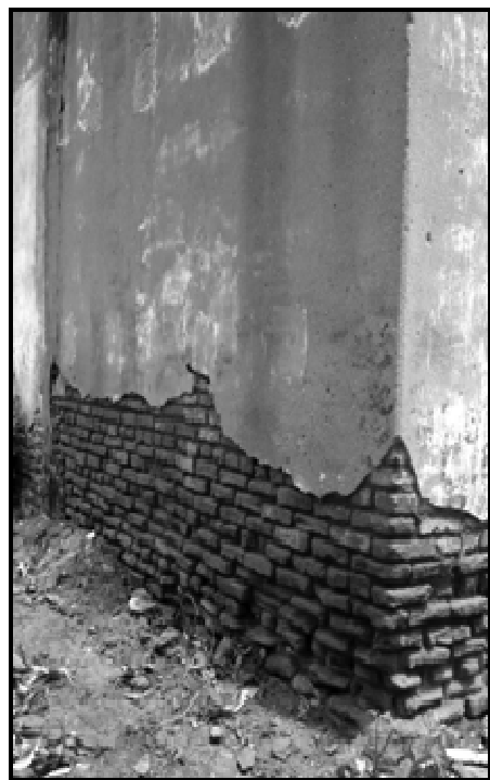
Fig. 4: Uso do tijolo no século XIX – exemplo de aplicação e do mau cozimento.
