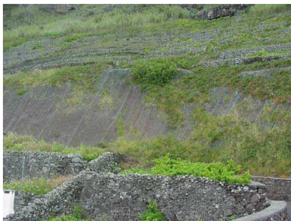
Baía da Maia. Proteção geotécnica do talude, com rede, de proteção à estrada (POOC Santa Maria)
