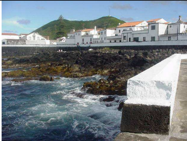
Santa Cruz. Estrutura aderente longitudinal junto do enraizamento do cais antigo (Graciosa).
