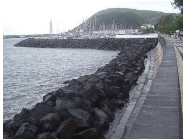
Marginal da Horta protegida com uma estrutura aderente longitudinal (Faial)
