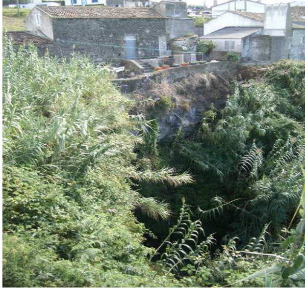
Grota do Araújo – Meio Moio. Acumulação de esgotos urbanos em poço formado no curso de água (São Miguel)
