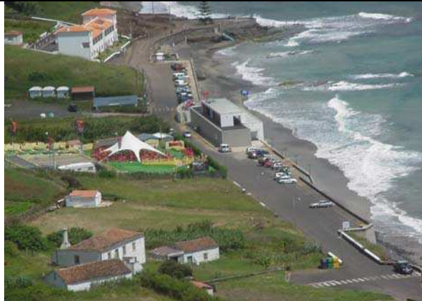
raia Formosa. Estacionamento avançado com obra aderente longitudinal recente. Restaurante “O Pacote” onde existia uma construção mais antiga (Santa Maria).
