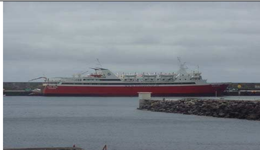
Porto de Vila do Porto (Santa Maria). Navio acostado no quebramar. Marégrafo na extremidade do novo cais. Foram identificados no POOC problemas operacionais relacionados com a agitação marítima na zona abrigada. Estes problemas poderão estar atualmente minimizados
