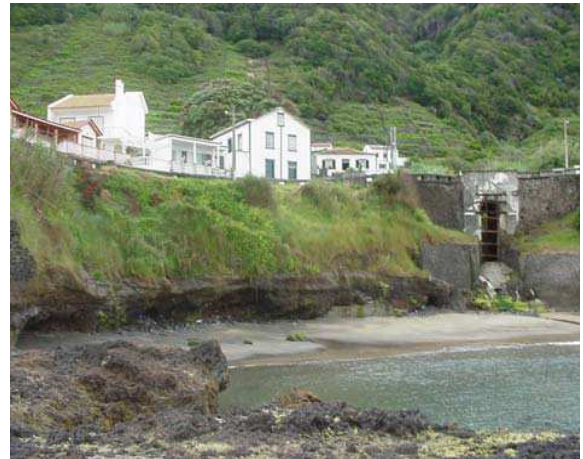
S. Lourenço. Passagem hidráulica escorada e arribas potencialmente instáveis (Santa Maria)
