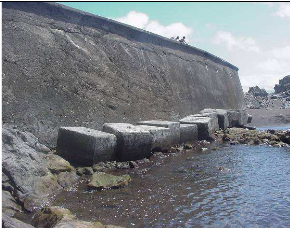
Estrutura aderente longitudinal no Portinho da Areia com blocos cúbicos em betão (Corvo).
