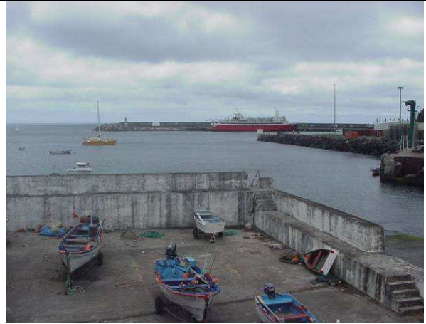
Porto de Vila do Porto. Em último plano, quebramar acostável (Santa Maria).
