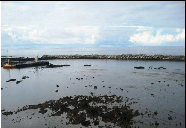
Porto das Lajes do Pico. Quebramar destacado (Pico).
