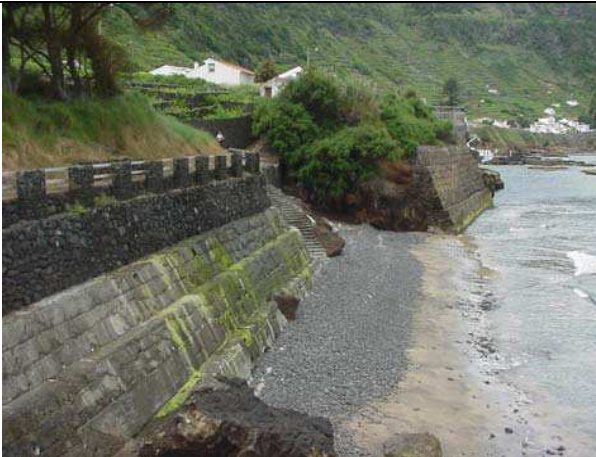
São Lourenço. Estruturas aderentes longitudinais com taludes. Praia com areia e calhau (Santa Maria).
