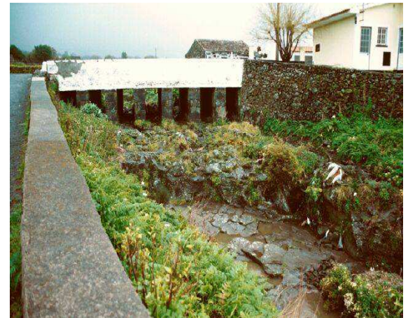
Passagem hidráulica com múltiplos pilares (Terceira).
