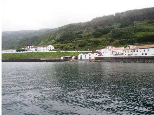
Estruturas aderentes longitudinais em Lajes do Pico (Pico).
