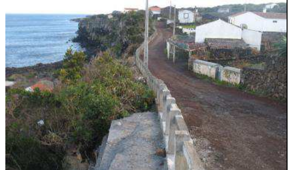
Arruamento pavimentado e edificações em risco em Calhau, Ponta da Baleia (Pico)
