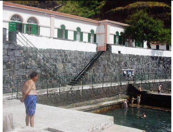
Estrutura aderente longitudinal. Termas do Carapacho. Detalhe junto da zona balnear (Graciosa).
