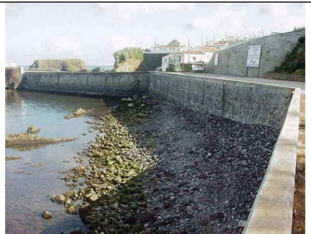
Estrutura aderente longitudinal a norte do Porto Velho de Santa Cruz (Flores)
