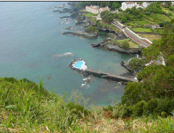
Estrada marginal de acesso ao porto da Caloura assente sobre maciços cavernosos (São Miguel)
