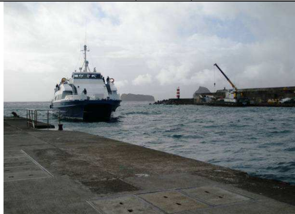
Porto da Madalena. Quebramar e cais acostável (Pico).
