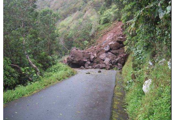
Deslizamento num acesso a uma fajã (São Jorge)
