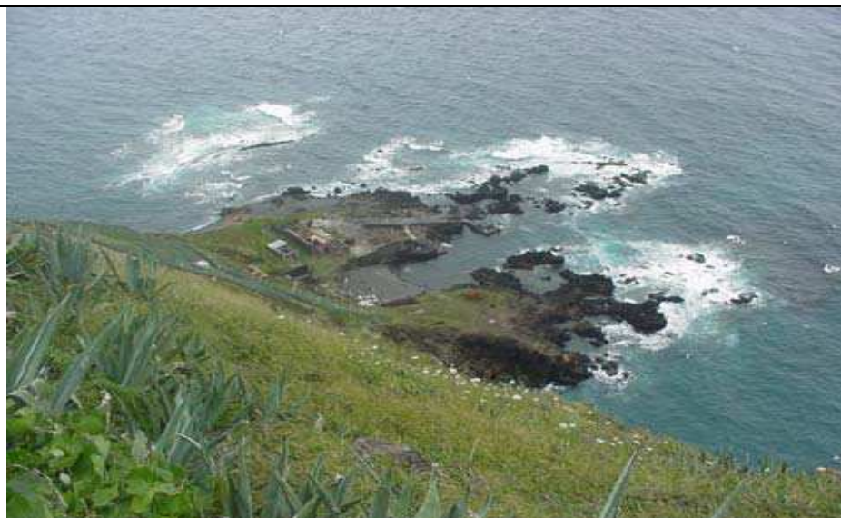
Portinho baleeiro do Castelo (Santa Maria). Proteções naturais, em rocha. Um dos muitos exemplos de portinhos com graves limitações em termos de condições de abrigo e aceso marítimo e terrestre
