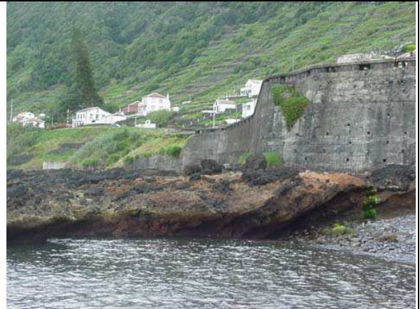
São Lourenço. Estrutura aderente longitudinal de grande altura, vertical (Santa Maria).
