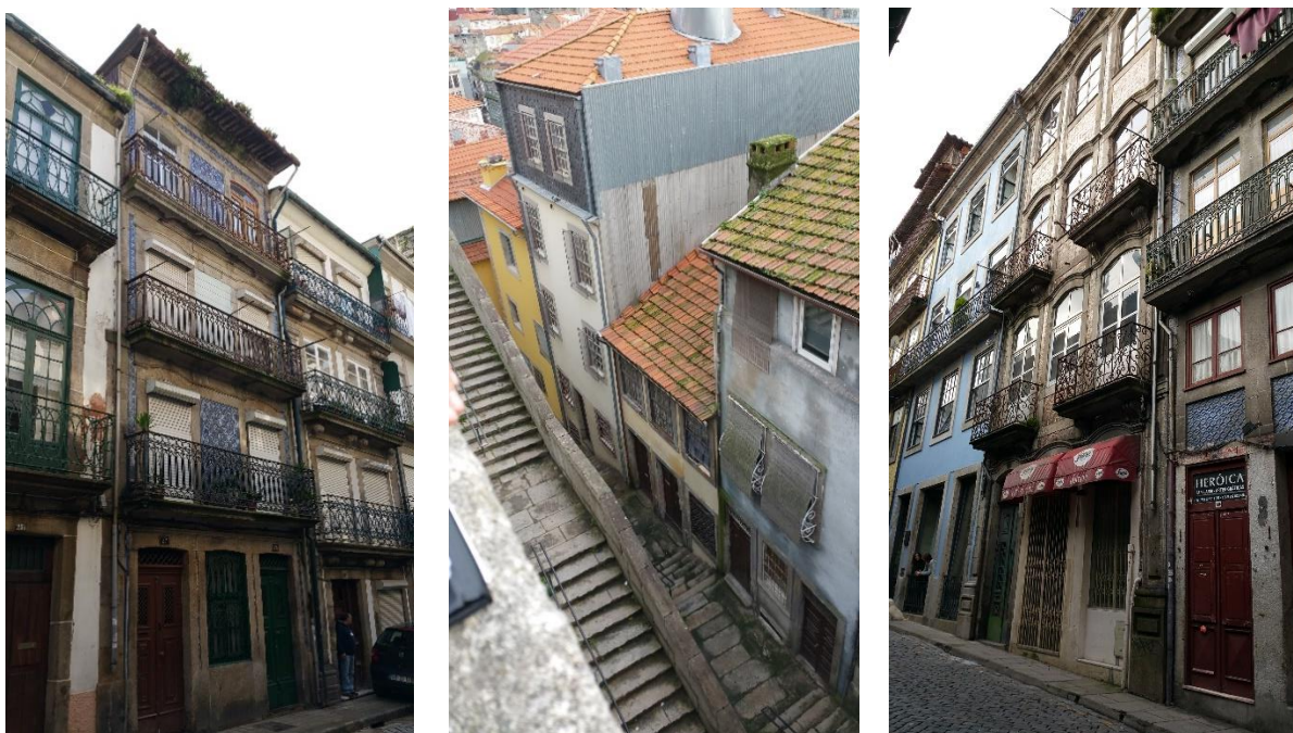
Fig. 3.2 - Fotografias de alguns edifícios em análise
