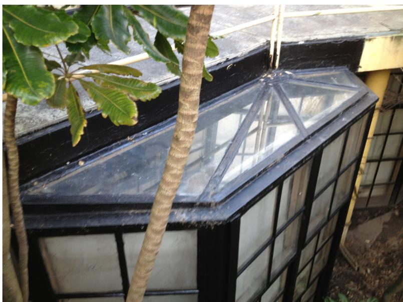
Fig.87 Claraboia da Parede-Cortina
