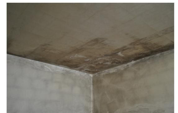
Fig.80 Condensação e Infiltrações no Quarto Principal
