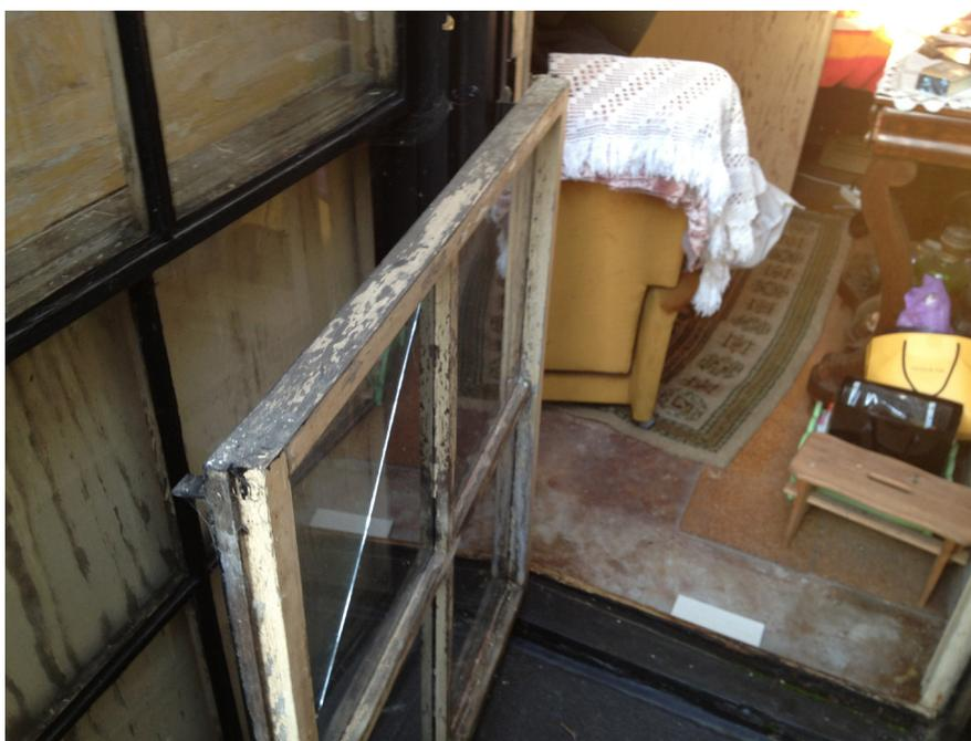
Fig.91 Folha de abrir da caixilharia do Piso 1 - degradação da madeira e vidros
