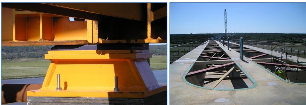
Fig.3.14 – Apoio de deslizamento (à esquerda) e sistema de travamento superior (à direita)
