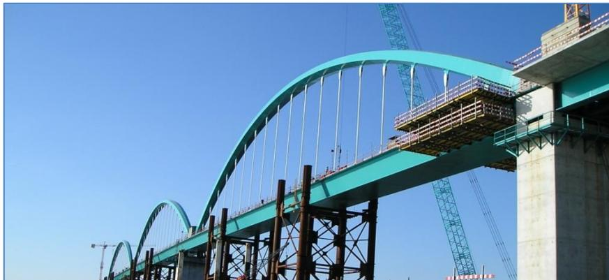
Fig.3.46 – Início da betonagem do tabuleiro da ponte com recurso a cofragem móvel
