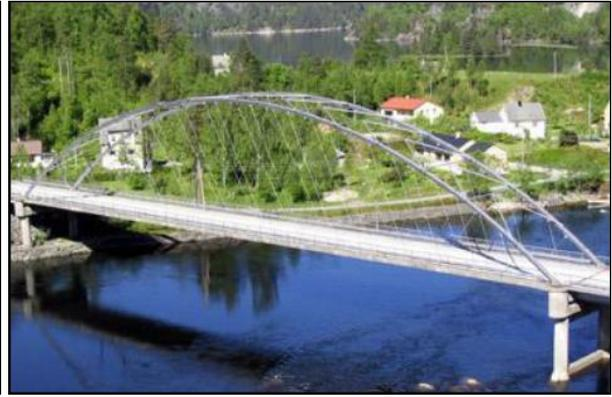
Fig.1.3 – Ponte Bolstadstraumen na Noruega. Vão principal com 84 m [8].
