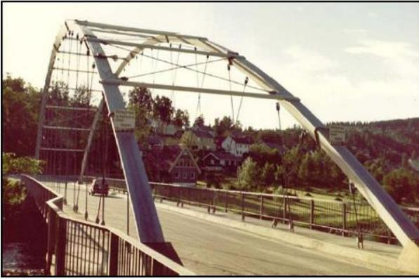
Fig.1.2 – Ponte em arco do tipo *Net* em Steinkjer, Noruega. Vão principal com 80 m [8].
