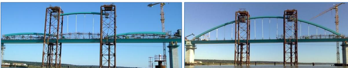
Fig.3.24 – Içamento do segmento central (à esquerda) e dos segmentos laterais (à direita)
