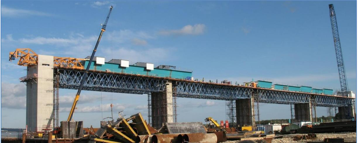
Fig.3.9 – Plataforma de lançamento do tabuleiro metálico
