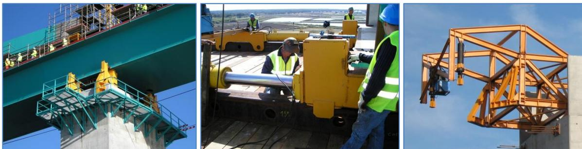
Fig.3.12 – Batentes laterais, macacos hidráulicos de empurre e macacos hidráulicos no “Nariz” metálico
