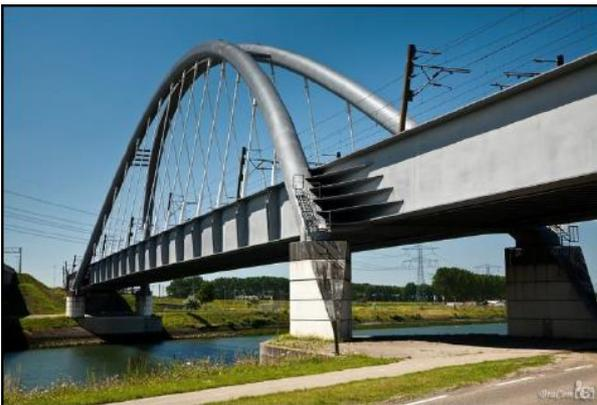
Fig.1.4 – Ponte ferroviária de via dupla em Roterdão, Holanda – sobre o Canal Hartel. Vão principal com 170 m [8].
