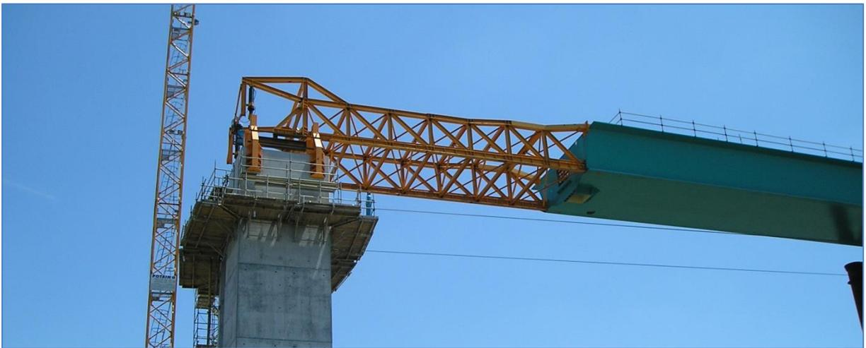
Fig.3.10 – Nariz metálico ("avant-bec")
