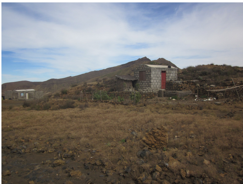
Fig. 32 Habitações construídas com a tecnologia das abóbadas.
