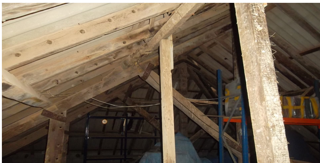
Fig. 71 Sótão - estrutura da cobertura em quatro águas.
