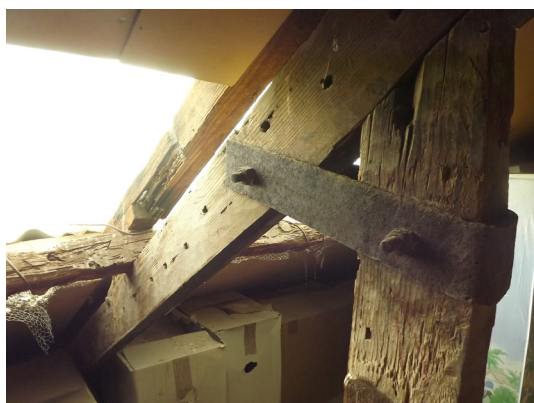
Fig. 72 Estrutura das asnas - travamento feito por tirante de ferro.
