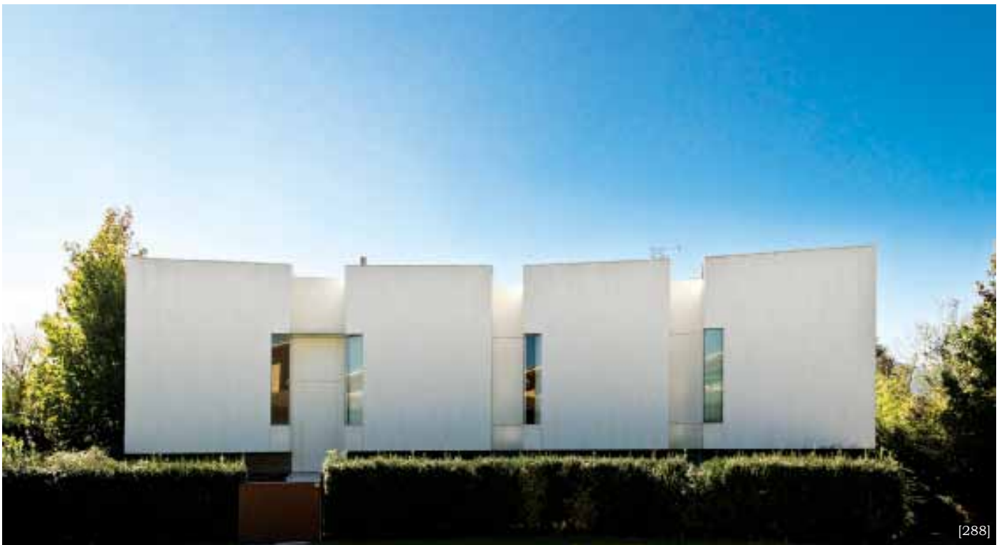
[288] Fachada orientada à rua.
