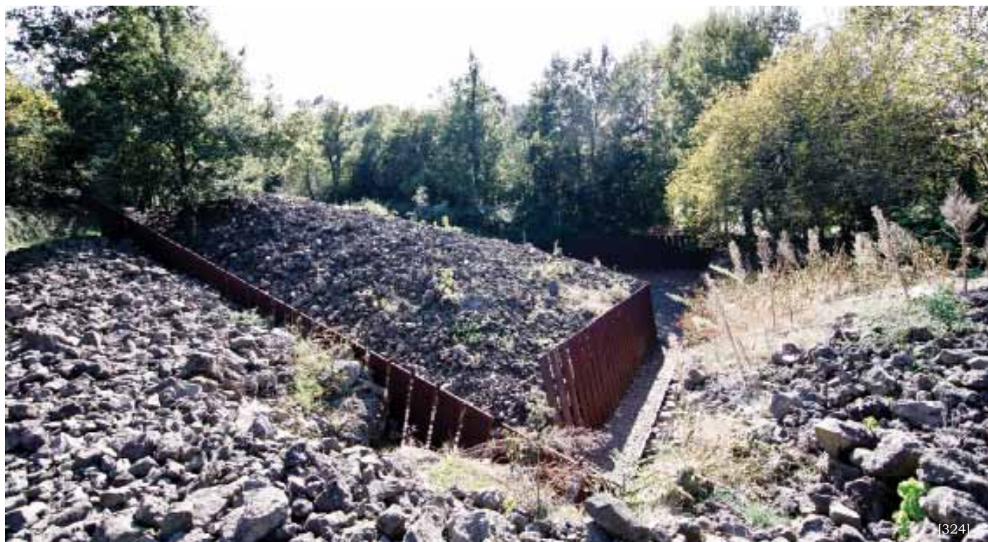
[324] Exterior do Parque da Pedra Tosca .
