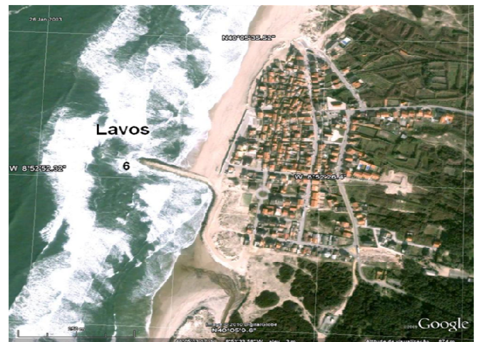
Figura 2. A “linha de costa” a norte e a sul das povoações defendidas encontra-se cada vez mais recuada em relação à frente marginal edificada (casos de Esmoriz, Cortegaça, Furadouro, Costa Nova, Vagueira, Lavos, Leirosa, Pedrógão).
