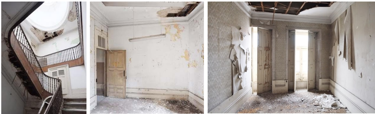
Figura 8: Fotos interiores do estado actual.
