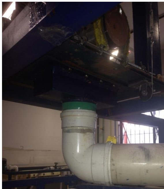
Figura 23 - Calha por onde cai a água no final do circuito
