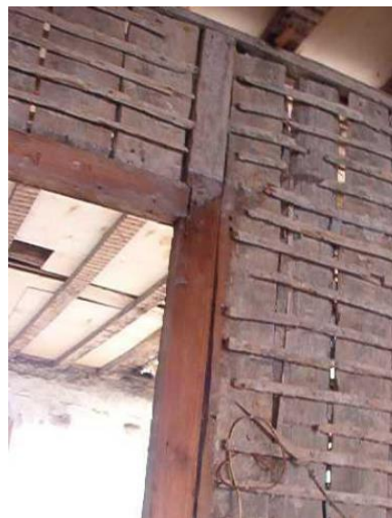
Fig. 3.4. - Parede interior em tabique [2]
