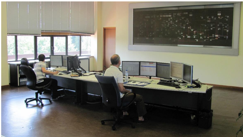
Figura 2.3: Instalações do COR (Vermoim, Maia). Fonte: Autor
