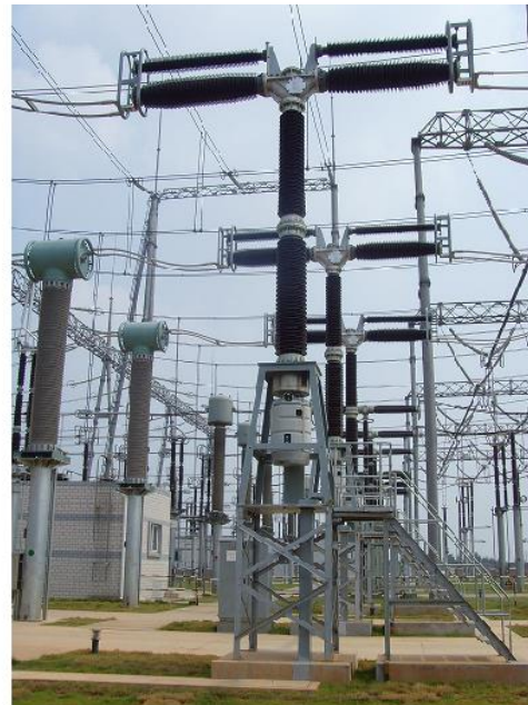
Figura 3.2: Configuração externa tipo dead tank (esquerda) e live tank (direita)
