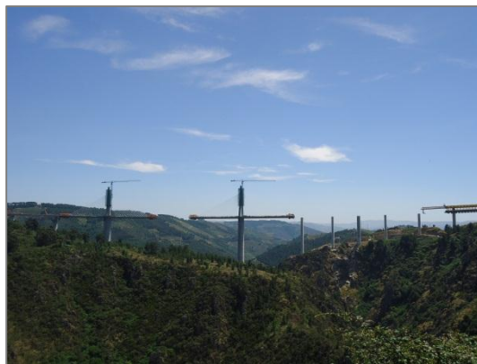
Fig. IV.8 – Vista da A4 - sul (2012)
