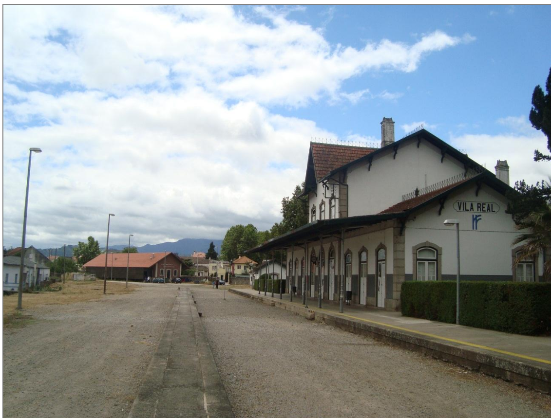
Fig. 3.1 – Estação Ferroviária de Vila Real (2012)
