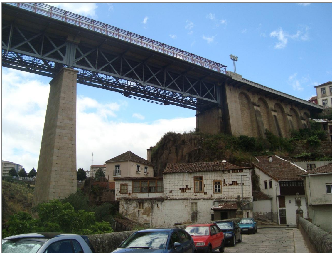
Fig. 1.6 – Ponte Metálica vista da Ponte de Santa Margarida (2012)
