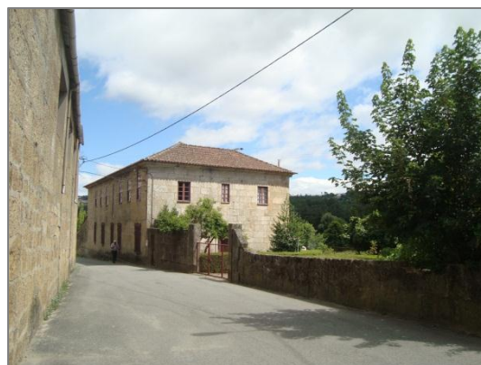
Fig. 4.49 – Vista da 'Casa-mãe' da Quinta (2012)
