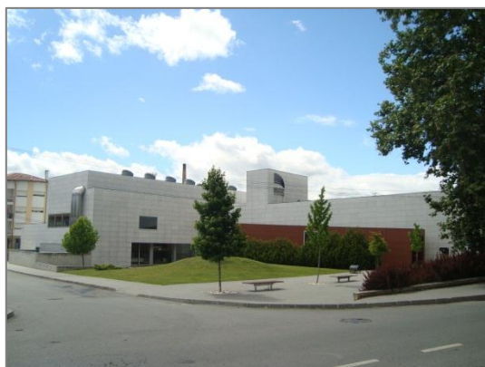
Fig. 4.38 – Vista da Biblioteca Municipal (2012)
