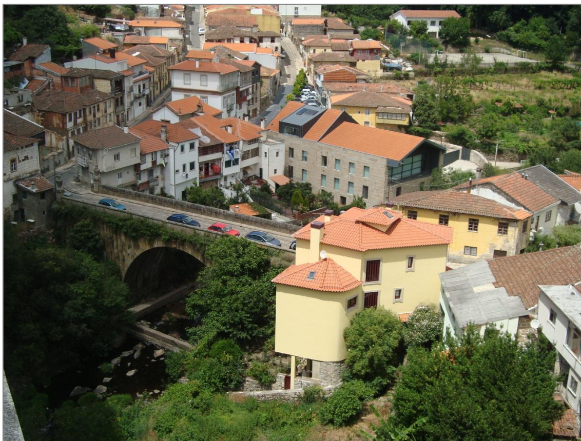
Fig. 1.4 – Ponte de Santa Margarida e envolvente (2012)
