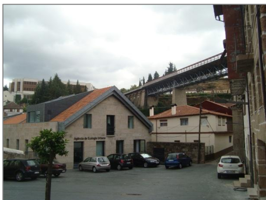
Fig. 4.32 – Vista do topo sul da rua do Corgo e da Agência de Ecologia Urbana (2012)
