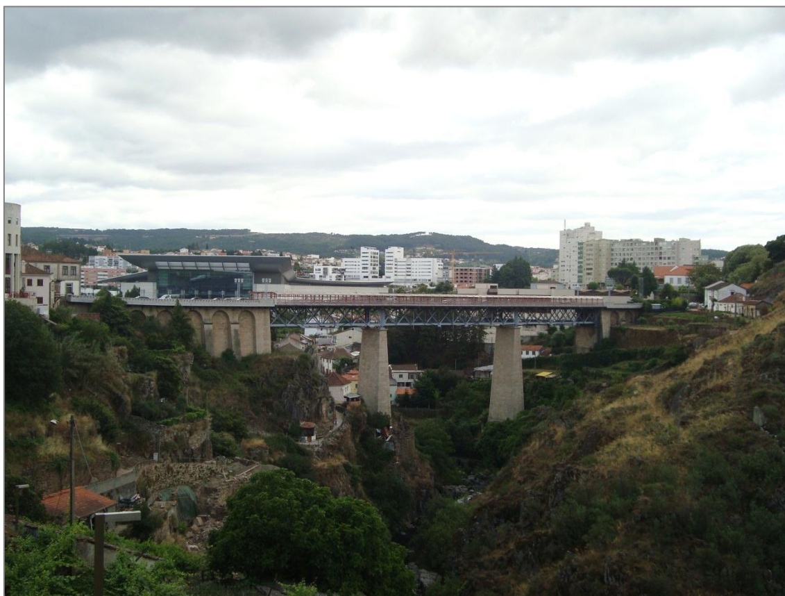
Fig. 3.2 – Ponte Metálica sobre o rio Corgo (2012)
