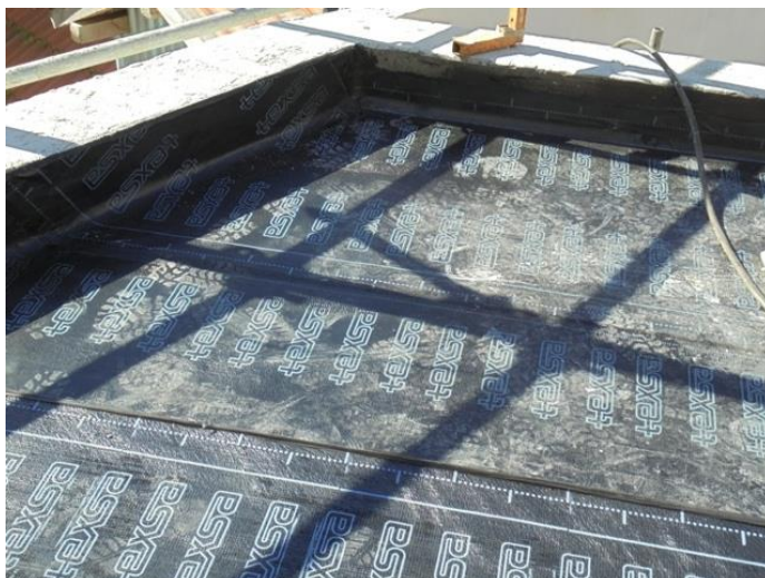
Fig. 3.39 - Impermeabilização da cobertura horizontal
