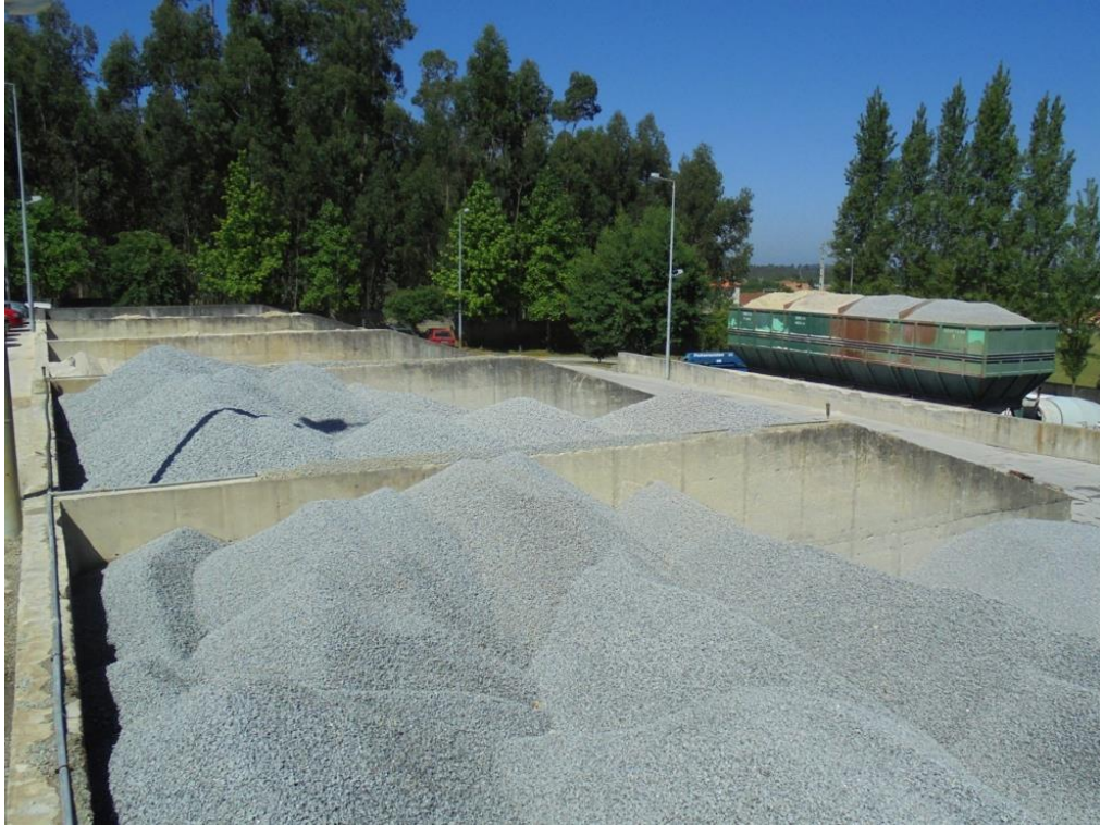
Fig. 2.10 - Depósitos para armazenagem de inertes
