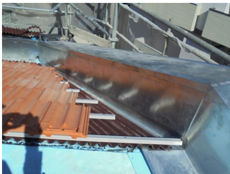
Fig. 3.34 - Telha e caleiros
