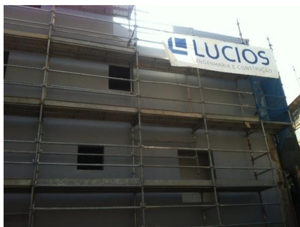
Fig. 3.47 - Pintura fachada nascente
