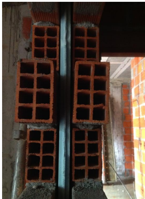
Fig. 3.7- Isolamento de uma parede interior entre frações
