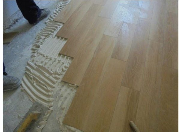
Fig. 3.42 - Aplicação de Cerâmicos
