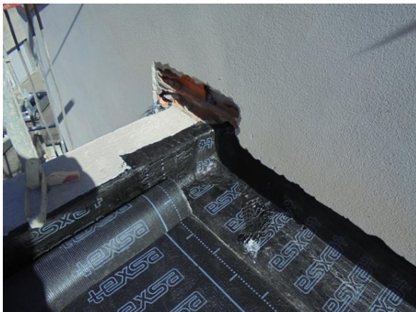
Fig. 3.37 - Membrana betuminosa
