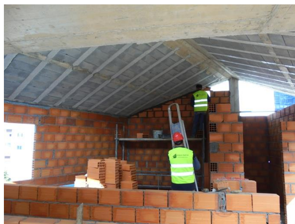
Fig. 3.9 - Cobertura após execução de alvenaria
