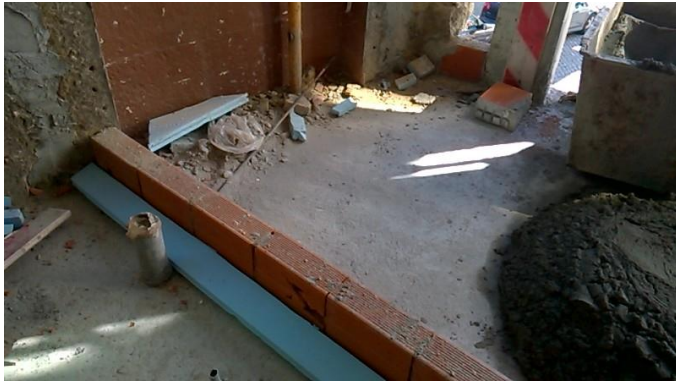
Fig. 3.5 - Marcação da primeira fiada
