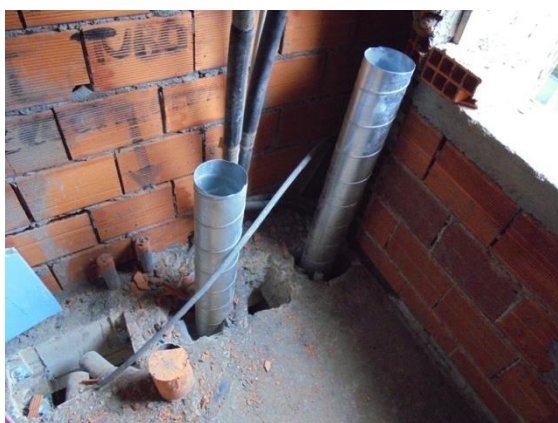
Fig. 3.17 - Instalação de tubagens de ventilação
