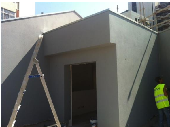
Fig. 3.44 - Execução de pinturas da zona da cobertura
