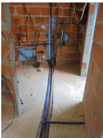
Fig. 3.19- Instalação de tubagens de águas
