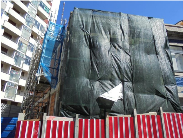
Fig. 3.12 - Andaime fachada principal
