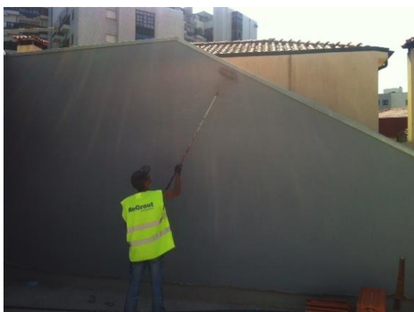
Fig. 3.46 - Execução de pinturas da zona da cobertura
