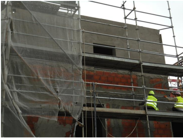
Fig. 3.21 - Reboco exterior fachada norte
