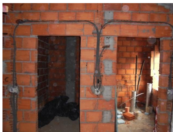
Fig. 3.18 - Instalação de tubagens de eletricidade
