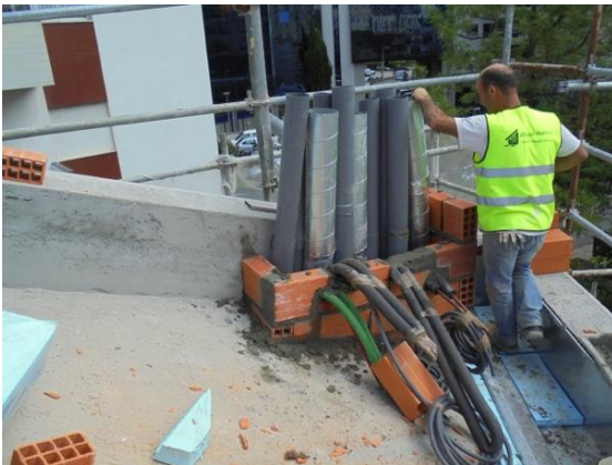
Fig. 3.29 - Execução da chaminé
