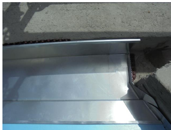
Fig. 3.27 - Chapa de zinco sobre membrana pitonada
