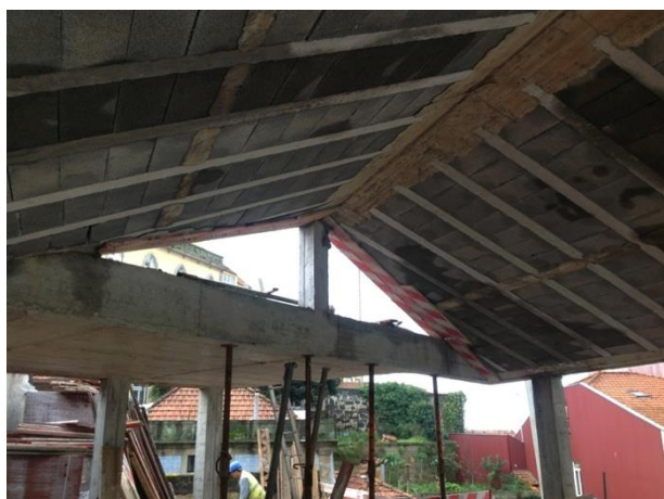
Fig. 3.8 - Cobertura antes da execução de alvenaria
