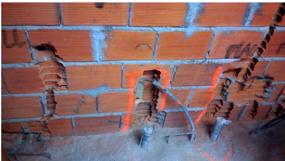
Fig. 3.14 - Abertura de rasgos na parede
