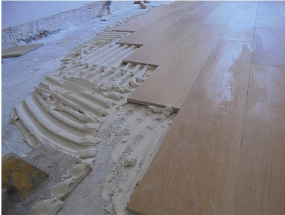
Fig. 3.41 - Aplicação de cerâmicos
