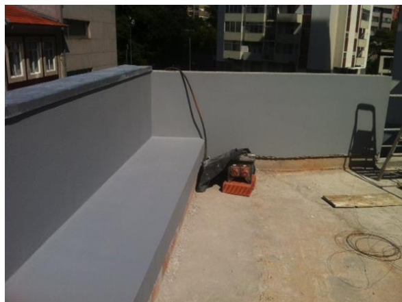
Fig. 3.45 - Execução de pinturas da zona da cobertura
