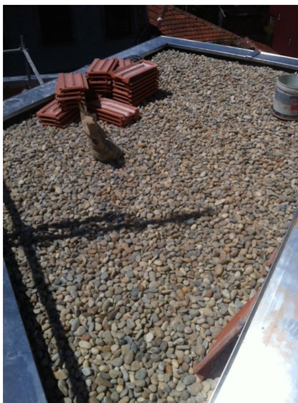
Fig. 3.40 - Revestimento de cobertura horizontal
