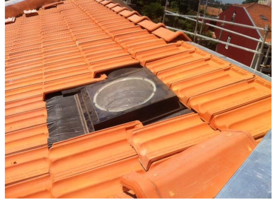
Fig. 3.36 - Execução da claraboia
