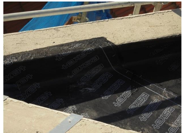
Fig. 3.38 - Remate da impermeabilização
