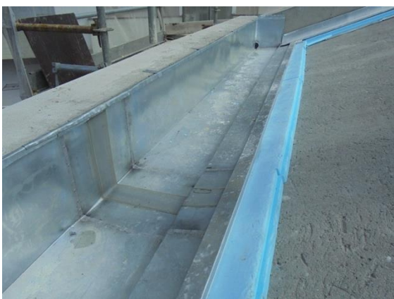
Fig. 3.26 - Chapa de zinco com junta
