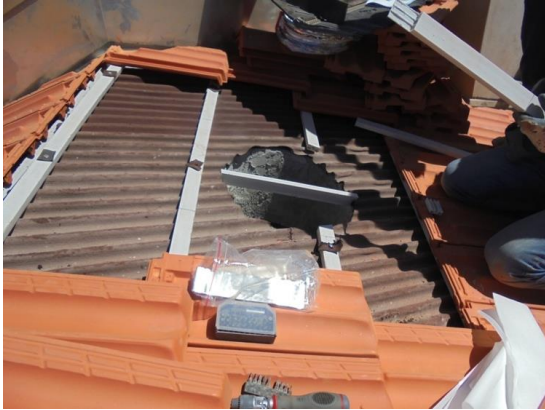
Fig. 3.35 - Execução da claraboia
