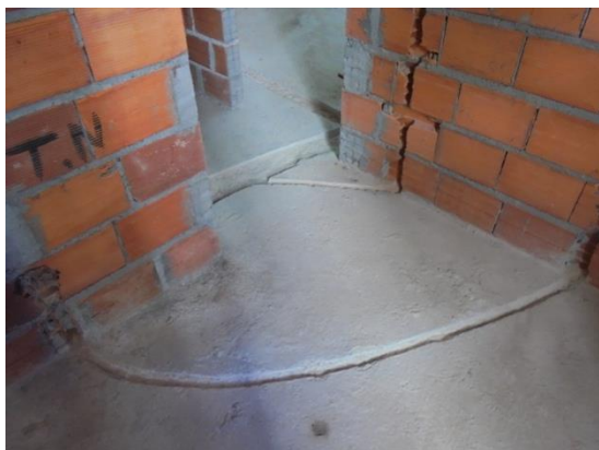
Fig. 3.15 - Abertura de rasgos no pavimento
