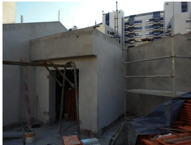
Fig. 3.23 - Reboco exterior no terraço
