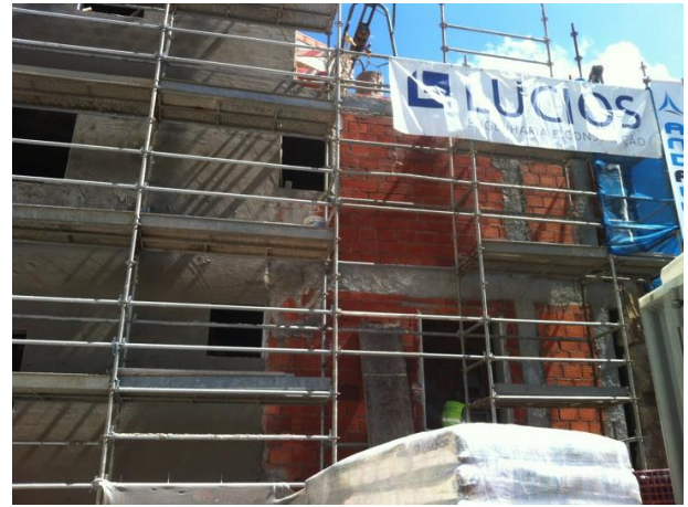
Fig. 3.22 - Reboco Exterior fachada nascente
