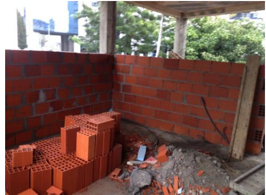
Fig. 3.6 - Execução de parede de alvenaria
