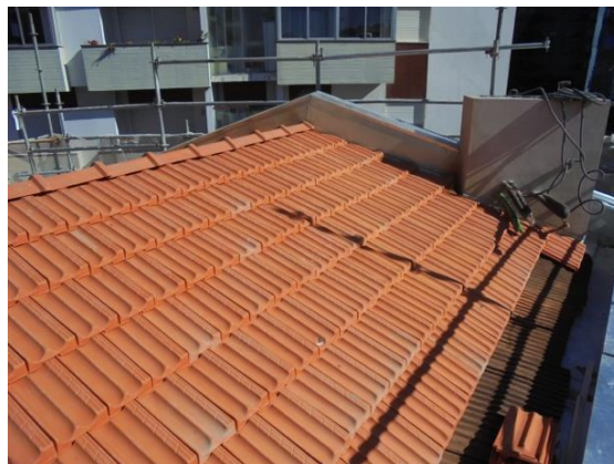
Fig. 3.33 - Telha na cobertura
