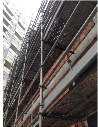
Fig. 3.13 - Andaime fachada poente
