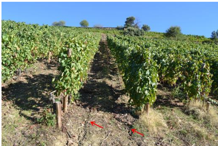
Figura 5 - Erosão por sulcos na Quinta de S. Luiz
