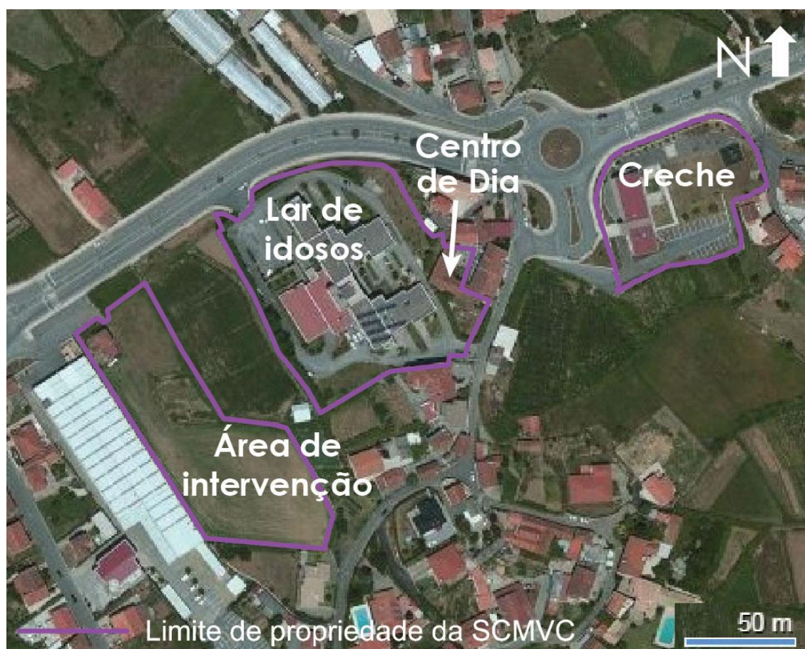
Figura 2 – Distribuição espacial dos equipamentos da SCMVC, próximos à área de intervenção (Fonte: Bing, 2014)
