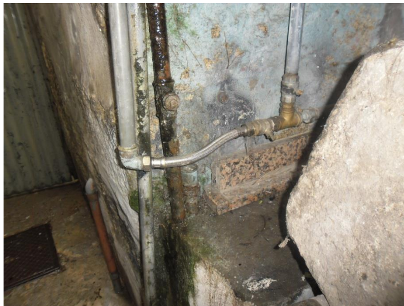
Fig. 2.14 - Ligação ilícita ao SAA do Porto.
