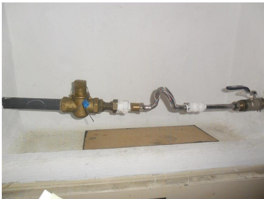
Fig. 2.18 - Ligação direta detetada no SAA do Porto.
