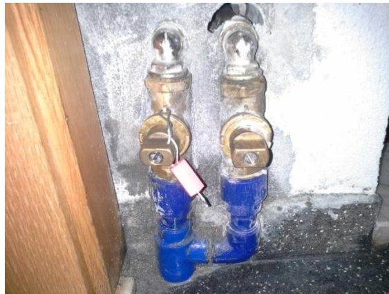
Fig. 4.12 – Reposição da suspensão do abastecimento de água após a deteção do ilícito I.
