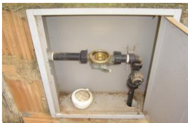
Fig. 2. 19 - Contador violado com quebra do lacre e relojoaria retirada (Pereira, 2007).
