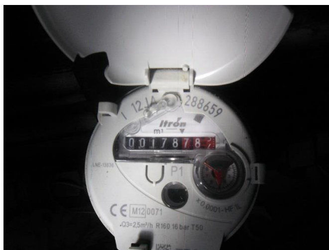
Fig. 4.57 - Leitura do contador após o corte do abastecimento de água do cliente XIII.
