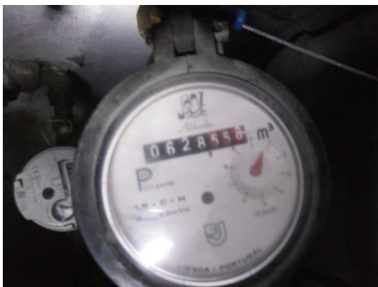
Fig. 4.51 - Leitura do contador após o corte do abastecimento de água do cliente X.
