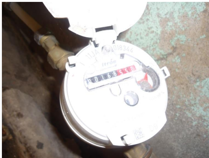
Fig. 4.63 - Leitura do contador após a suspensão do fornecimento de água do cliente XVI.
