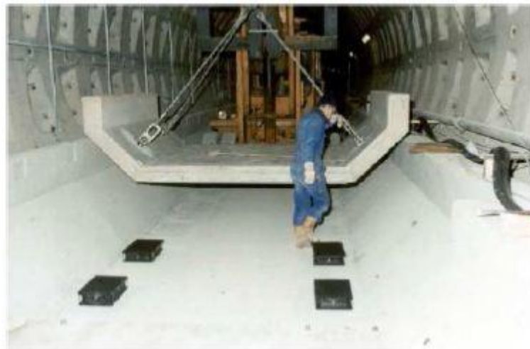
Fig.2. 15 - Sistema de Laje Flutuante (Koroma (2014)).
