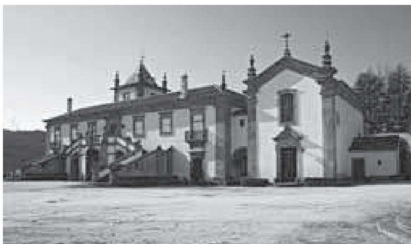
Figura n.º 4 Marco de Canaveses – Soalhães – Casa da Quintã
