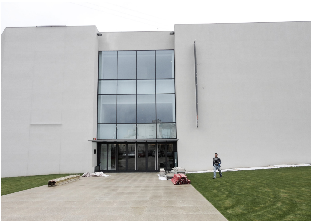
33. Alçado sul, após intervenção.
