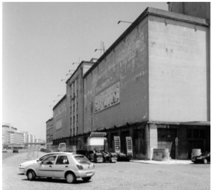
12. Alçado norte antes da intervenção.
