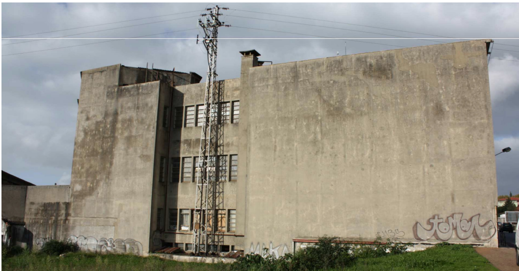
21. Alçado sul, antes da intervenção.
