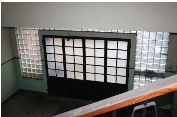
13. Vista interior da entrada nascente.
