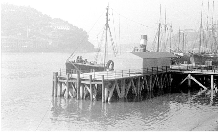
19. Vista geral da ponte prancha.
