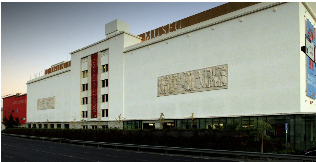
46. Vista geral do alçado norte a partir da rua.
