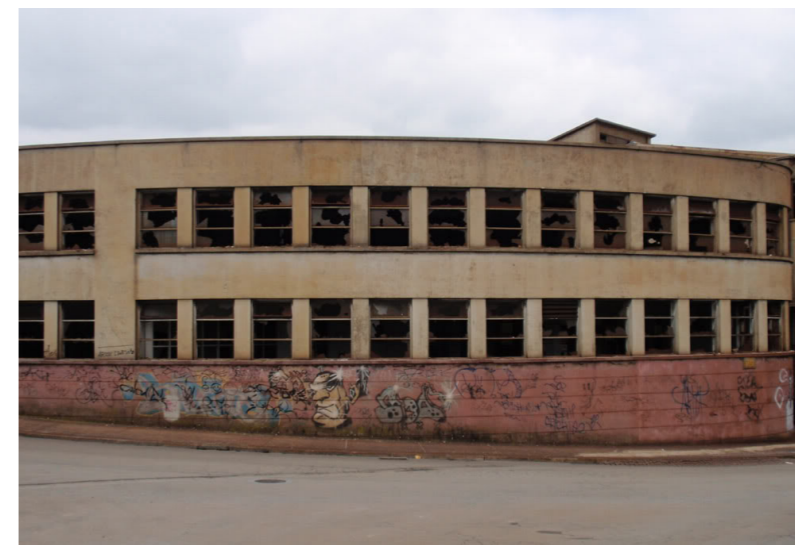
38. Gaveto dos Armazéns Fundidos.
