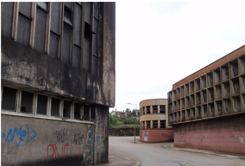
41. Vista dos dois volumes a partir da Rua da Fundição.
