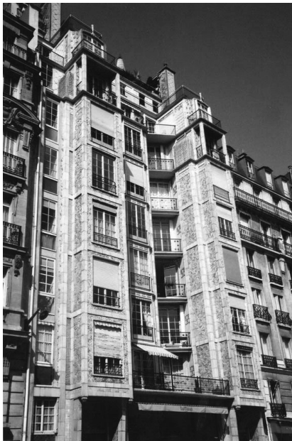
11. Apartamentos na Rue Franklin, Paris. Auguste Perret
