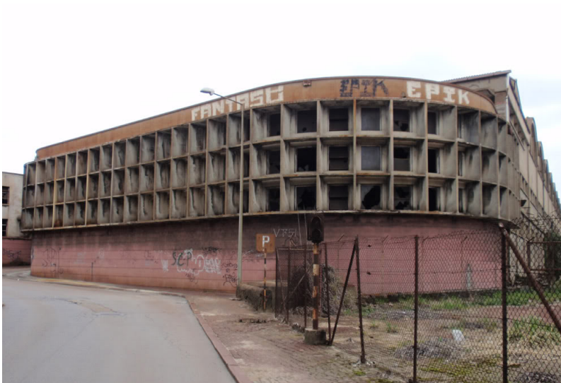
40. Gaveto do Edifício de Fabricos Gerais.
