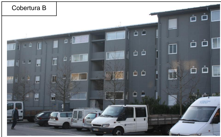
Fig.13 – Fotografia de edifícios com cobertura inclinada em painel sandwich (Bairro de Contumil) [11]
