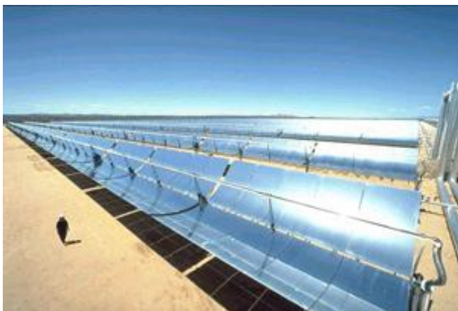
Figura 2-4 - Representação de um sistema de concentração solar de 1 eixo, de [25]
