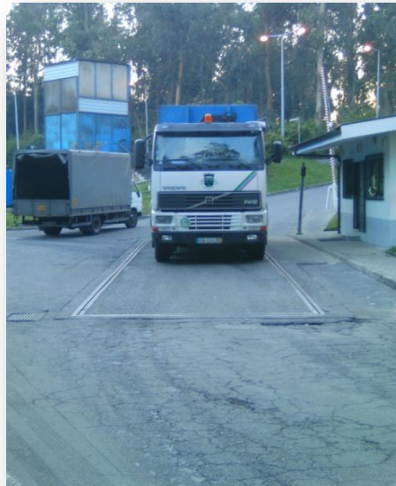
Ilustração 14 - Pormenor da báscula e de uma viatura a ser pesada, após a carga de resíduos sólidos urbanos para aterro.
