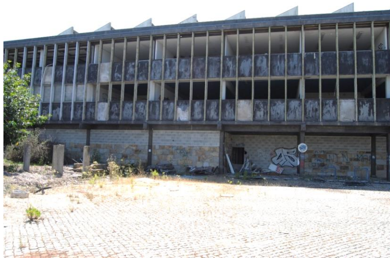
Fig. 3.18- Entaipamento de portas e janelas (Leça do Balio)
