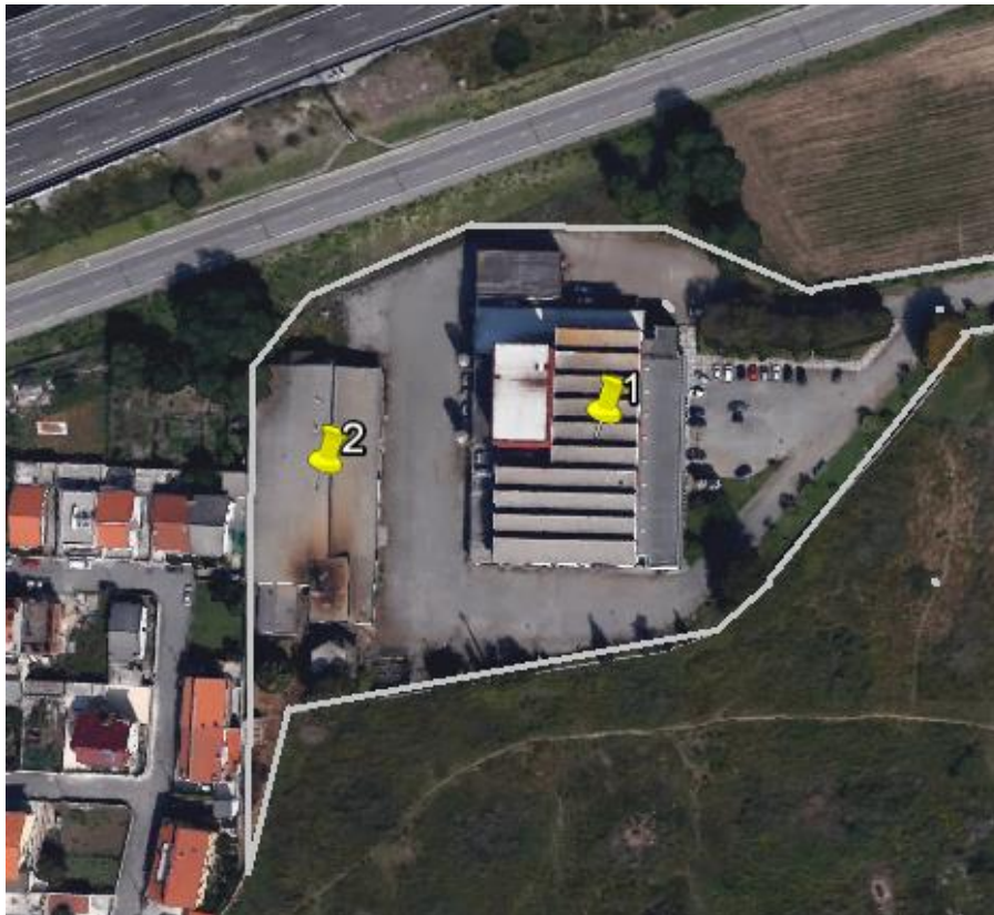
Fig. 5.7.- Edifícios principais da unidade industrial (Leça do Balio)
