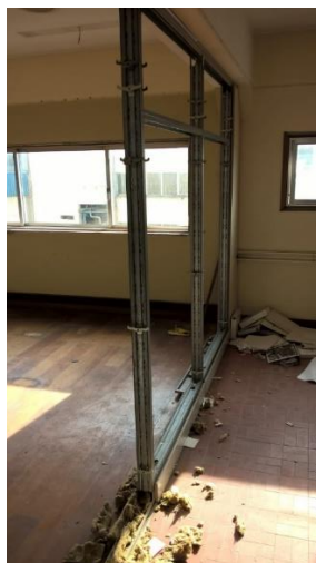
Fig. 3.11.- Divisórias amovíveis (Vila do Conde)
