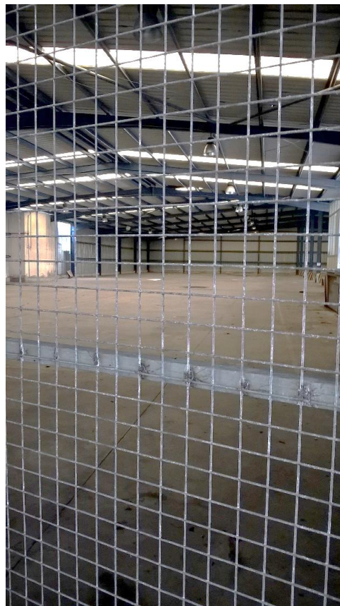
Fig. 3.7.- Estrutura edifício 4 (Vila do Conde)
