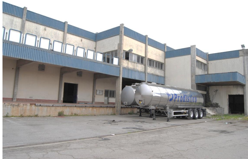
Fig. 3.6.- Fachada edifício 2 (Vila do Conde)
