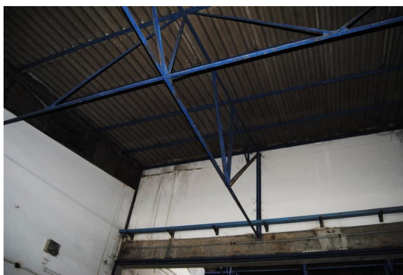
Fig. 3.16- Cobertura edifício 2 (Leça do Balio)
