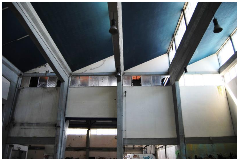
Fig. 3.15- Cobertura edifício 1 (Leça do Balio)
