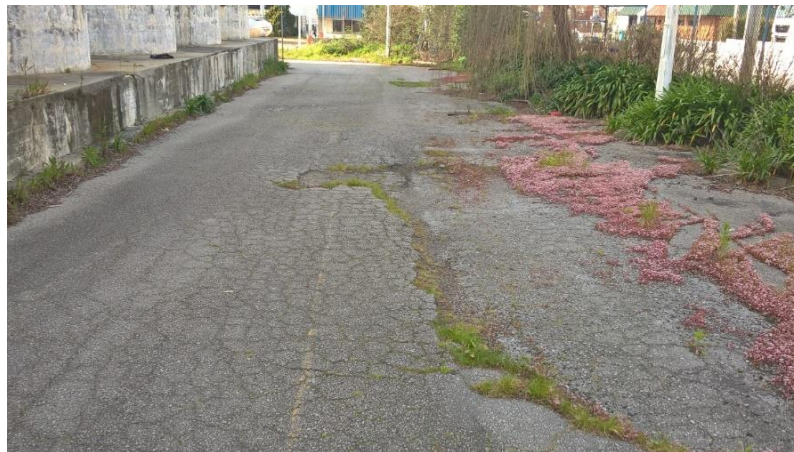
Fig. 3.23.- Pavimento exterior (Vila do Conde)
