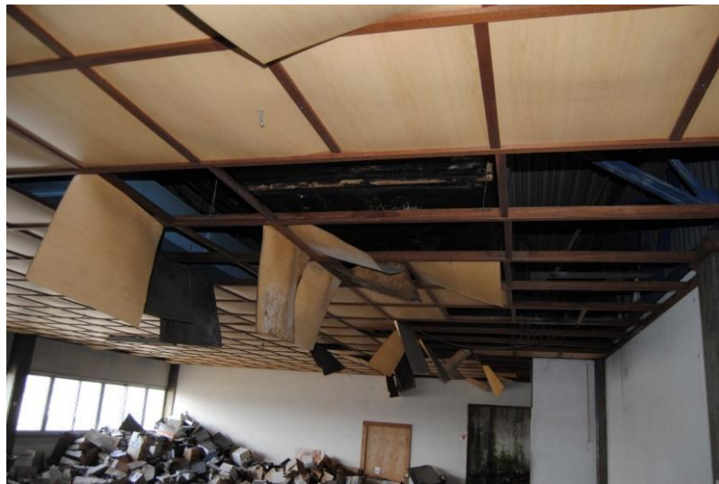
Fig. 3.8.- Tetos falsos (Vila do Conde)
