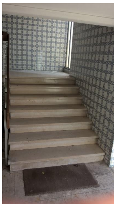
Fig. 3.10.- Escada edifício 3 (Vila do Conde)
