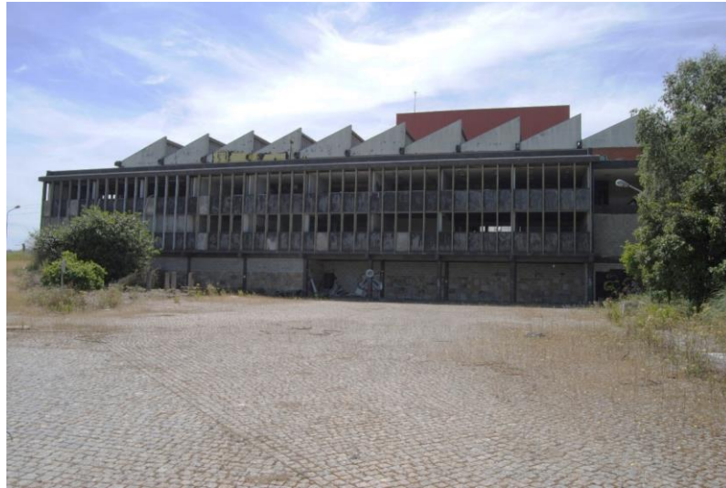
Fig. 3.38.- Cortina de vidro edifício 1 (Leça do Balio)
