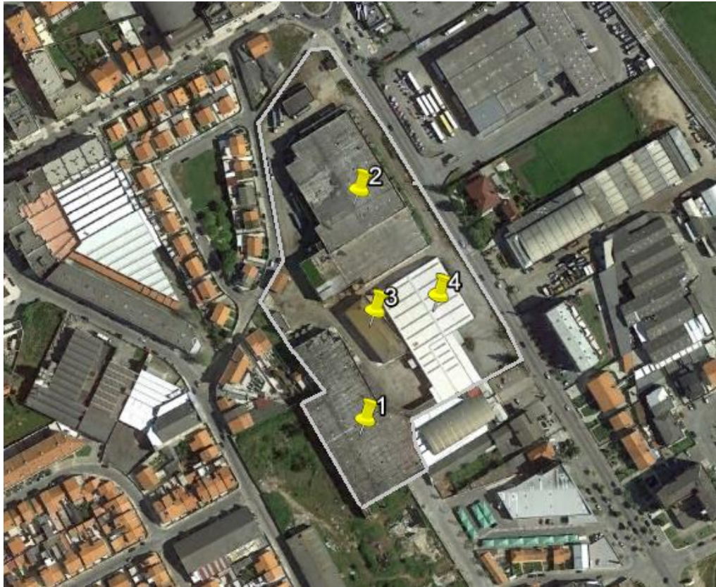
Fig. 5.1- Edifícios principais da unidade industrial (Vila do Conde)
