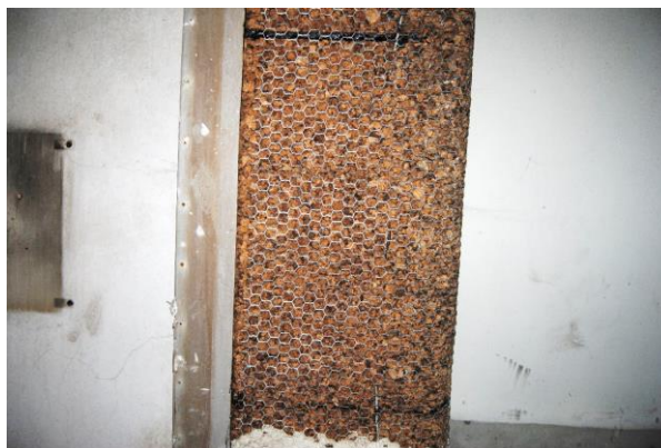
Fig. 3.12.- Isolamento térmico câmaras frigoríficas (Vila do Conde)
