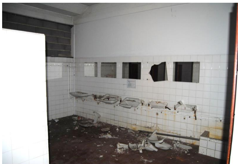
Fig. 3.41- Casa de banho (Leça do Balio)
