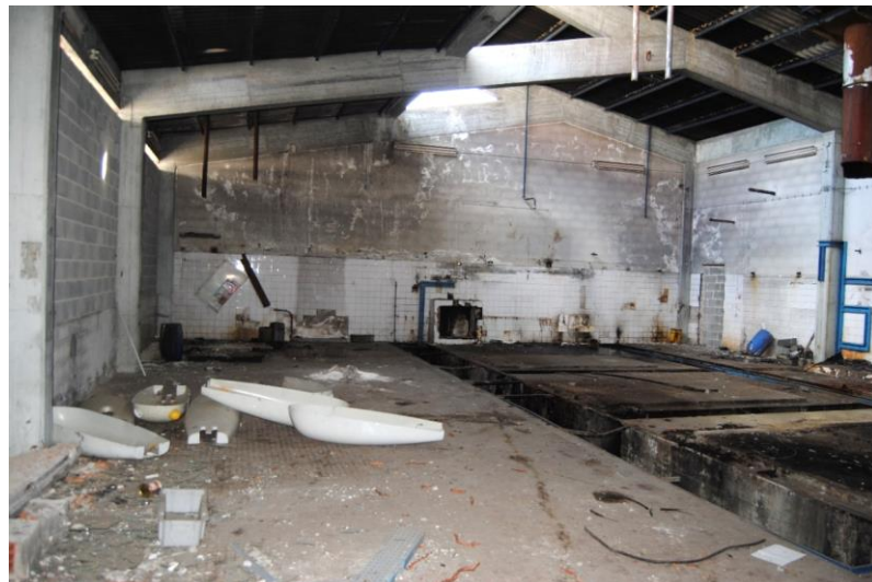
Fig. 3.31.- Paredes exteriores edifício 2 (Leça do Balio)
