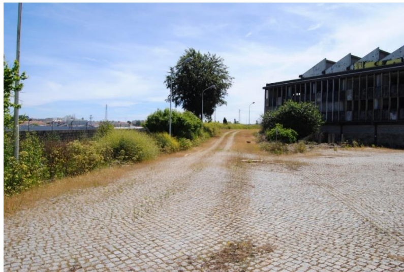
Fig. 3.43.- Pavimentos exteriores (Leça do Balio)
