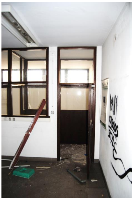
Fig. 3.40.- Portas e janelas na zona de laboratórios (Leça do Balio)
