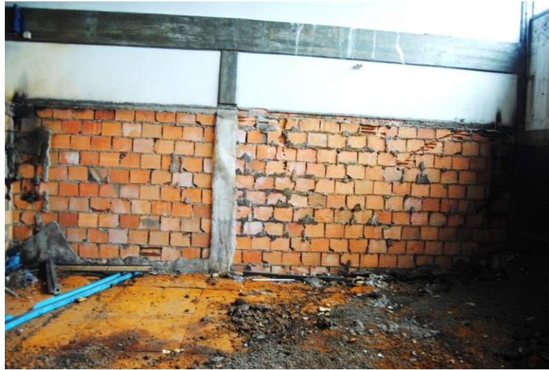
Fig. 3.10.- Parede fachada edifício 2 (Vila do Conde)
