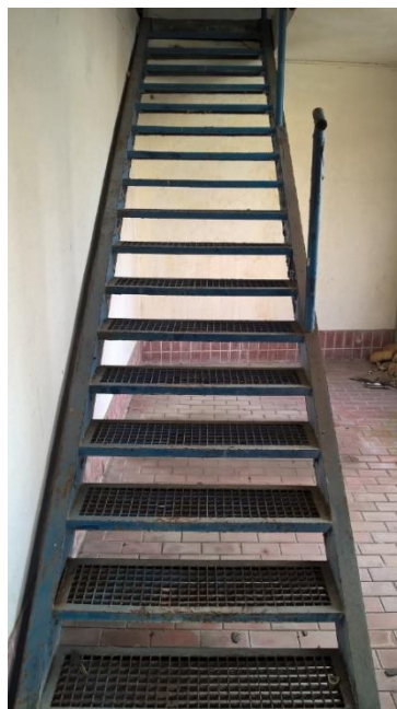
Fig. 3.9.- Escada metálica (Vila do Conde)
