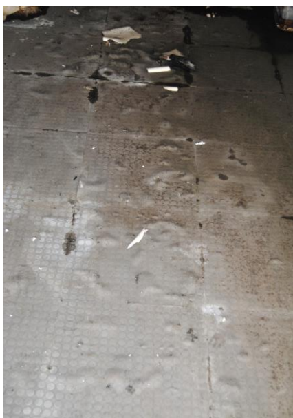
Fig. 3.13.- Revestimento de pavimento em linóleo (Vila do Conde)
