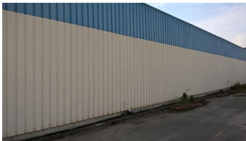
Fig. 3.9.- Fachada edifício 4 (Vila do Conde)
