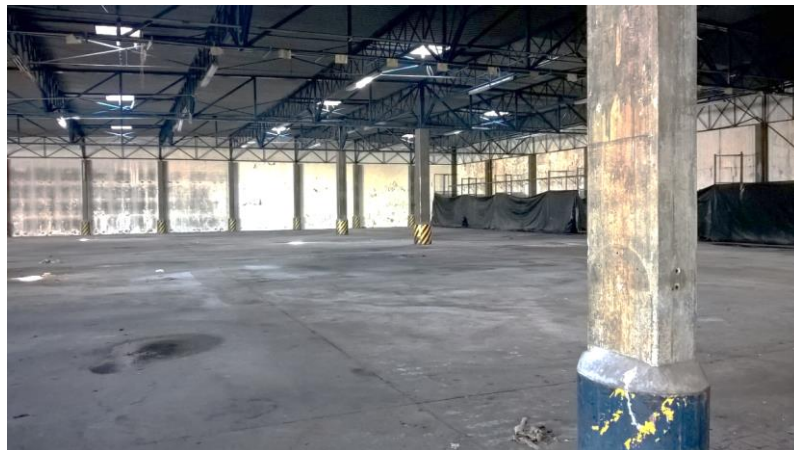
Fig. 3.8.- Cobertura edifício 1 (Vila do Conde)
