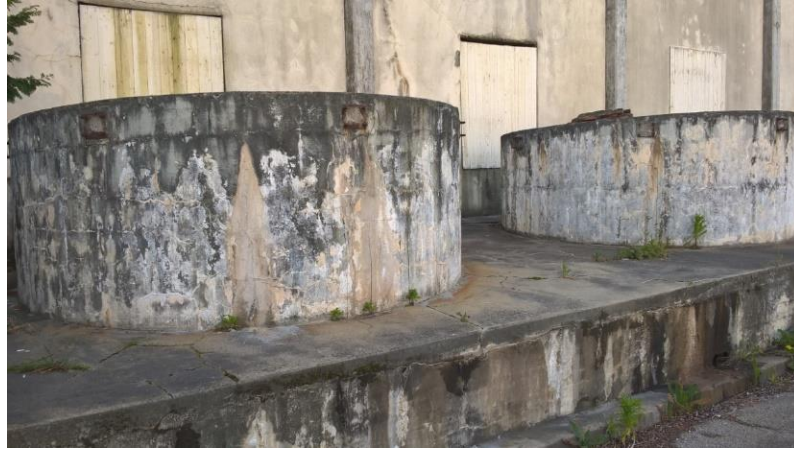
Fig. 3.22- Depósito (Vila do Conde)
