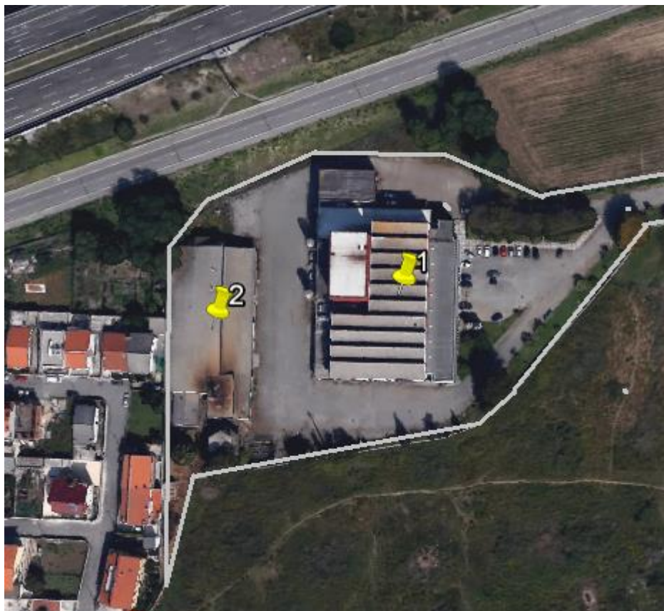
Fig. 3.5.- Identificação do edificado (Leça do Balio)
