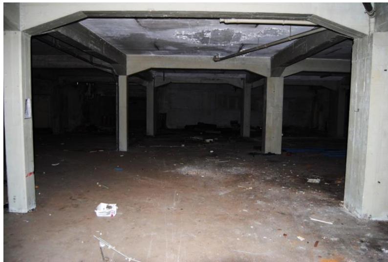
Fig. 3.13- Estrutura em betão armado (Leça do Balio)
