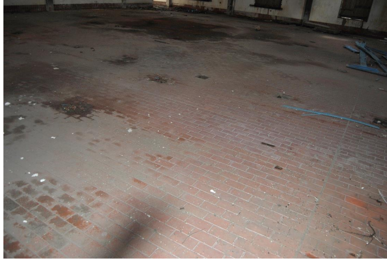
Fig. 3.7.- Revestimento cerâmico de pavimento (Vila do Conde)
