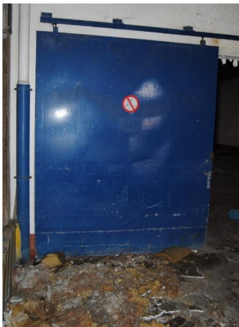
Fig. 3.20.- Porta interior edifício 2 (Vila do Conde)
