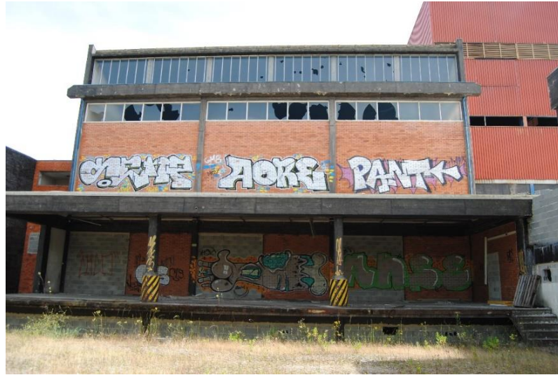
Fig. 3.30.- Parede exterior edifício 1 (Leça do Balio)
