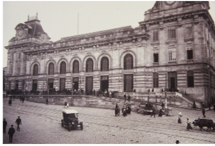
Figure 4 – Estação de S. Bento 1900-1909. Marques da Silva
