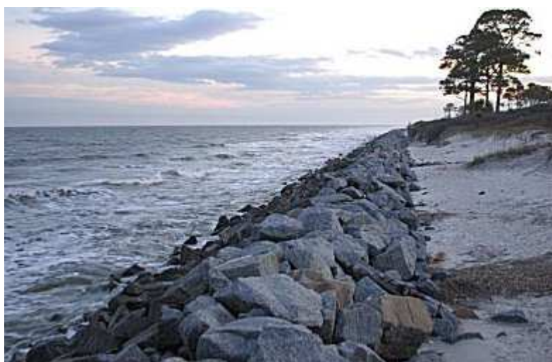
Figura 3 – Exemplo da aplicação do sistema Rip-Rap
