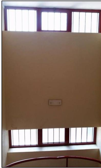
Fig. 4.39 – Janelas do topo das vias de evacuação verticais
