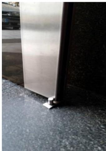
Fig. 4.33 – Sistema de batente de travagem de porta
