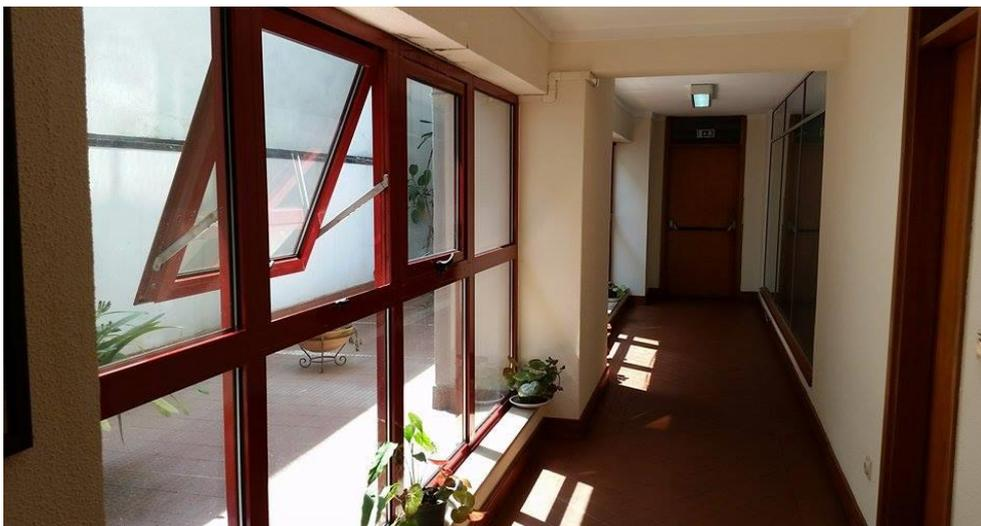
Fig. 4.40 – Janelas na via de evacuação horizontal
