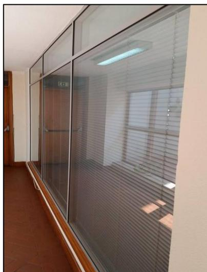
Figura 5.3 – Envidraçado na via de evacuação horizontal – 1º piso
