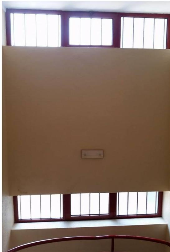
Figura 5.9 - Janelas basculantes nas vias de evacuação verticais
