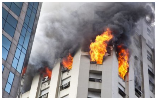
Figura 5.3: Fogo de origem elétrica
