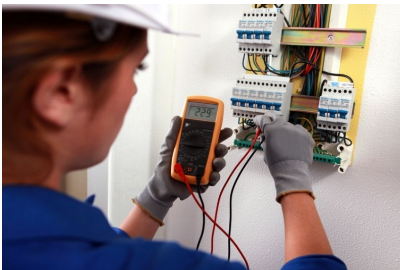
Figura 6.1: verificação técnica de um quadro elétrico muito simples
