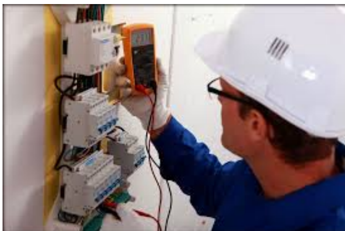
Figura 4.1: Técnico Responsável a verificar um quadro elétrico
