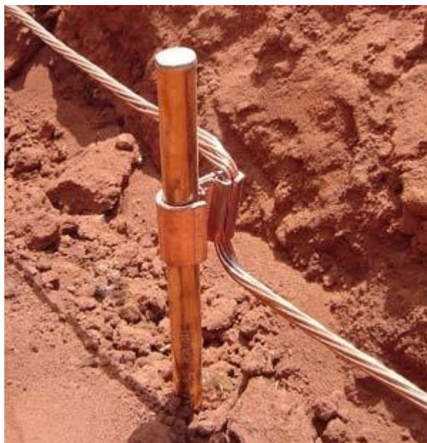
Figura 2.1: Eléctrodo de terra enterrado no solo
