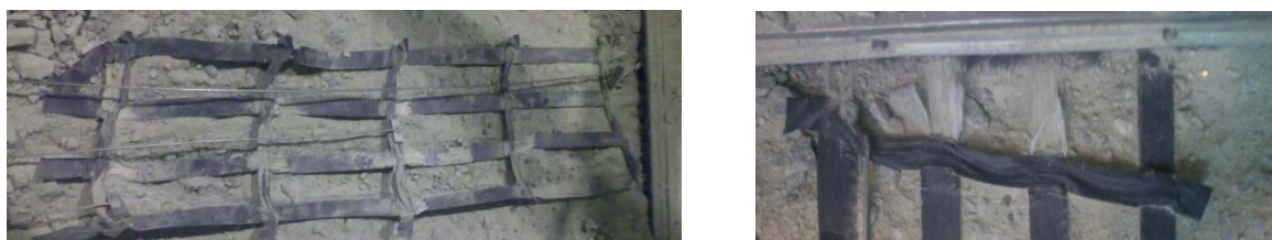
Figura 5.39 - Fotografias de provetes do GC1 intacto após ensaio de arranque.
