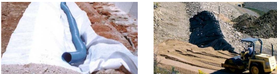
Figura 1.15 - Função de filtro dos geossintéticos.
