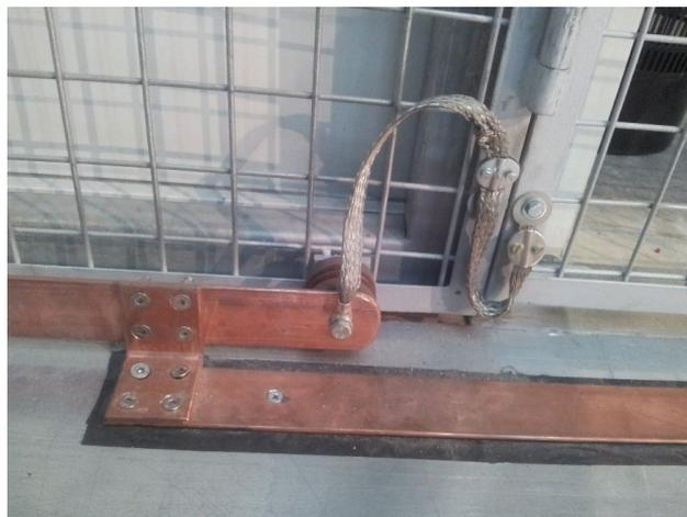
Figura 7.3: Pormenor do barramento de terra na travessa da porta de entrada para a sala de comando e ligação da rede de proteção ao mesmo.
