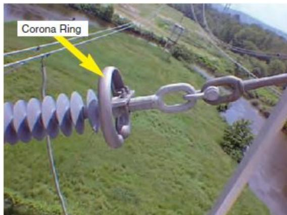
Figura 5.8: Exemplo de aplicação de anel de coroa num isolador composto [21].
