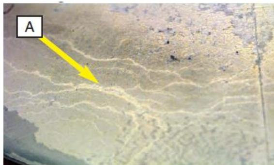
Figura 4.4: Exemplo de fissuras nas abas do revestimento [22].
