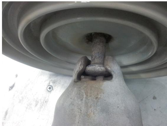
Figura 2.3: Conexão entre campânula e espigão.
