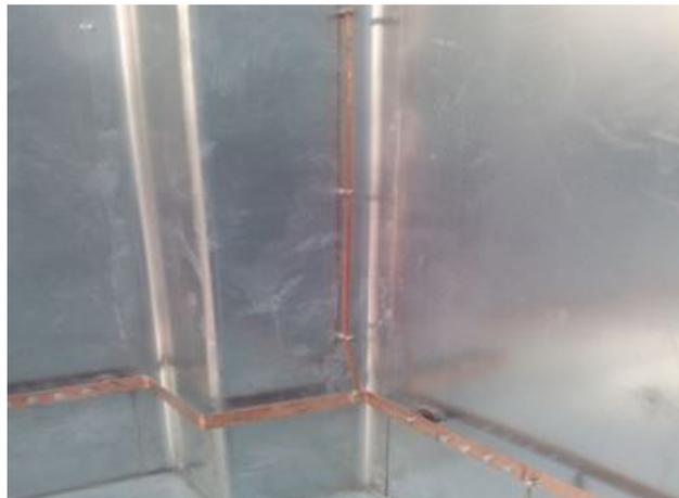
Figura 7.2: Interligação entre anel superior e anel principal.
