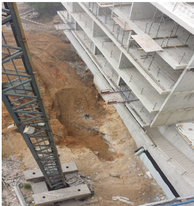
Figura 13 – Vista geral sobre o bloco B.
