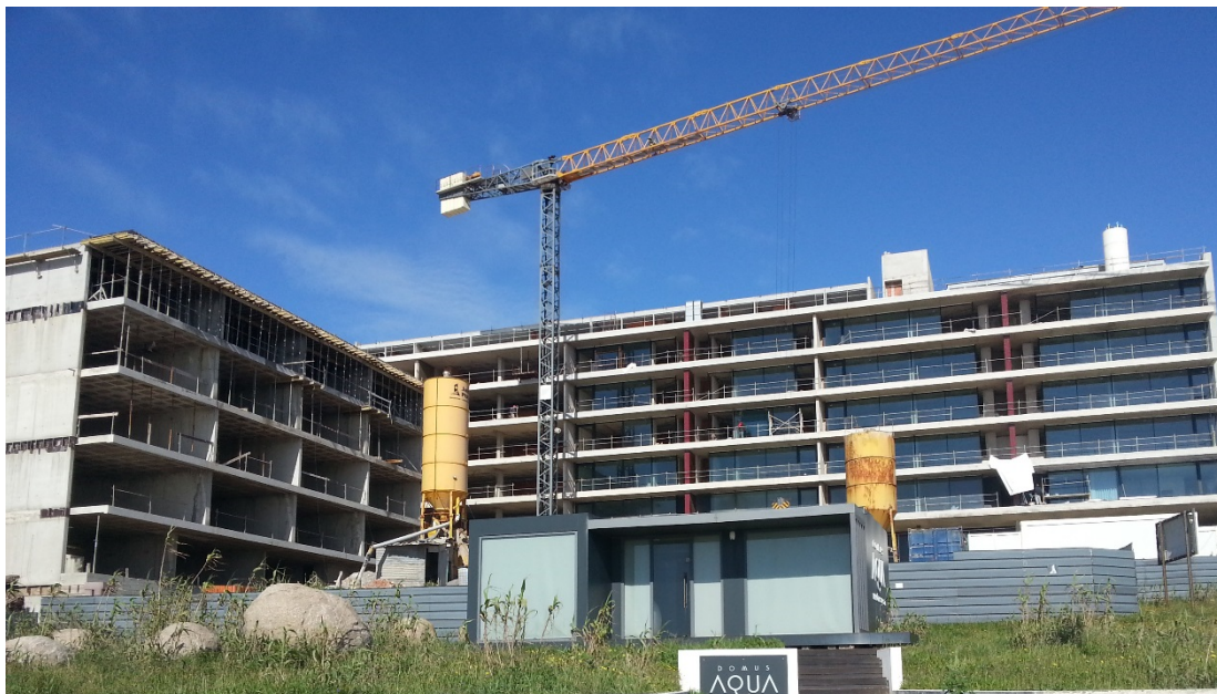
Figura 11 – Vista geral da obra na altura de recolha dos dados.
