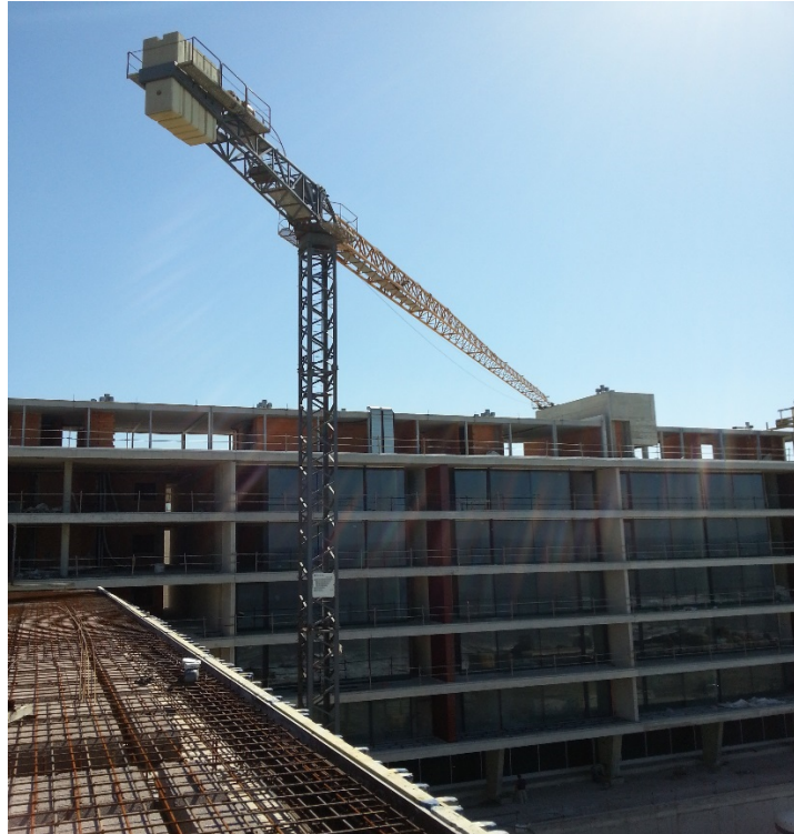
Figura 12 – Vista geral sobre o bloco A.
