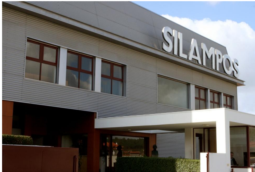
Figura 1: Instalações da Silampos (Fonte: Silampos)
