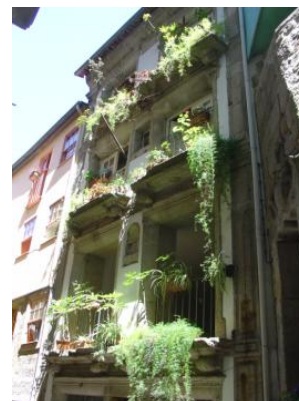
Figura 3.8 - Vegetação na fachada de edifício antigo
