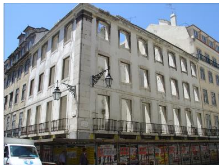
Figura 2.6 - Reconstrução de um edifício mantendo as fachadas
