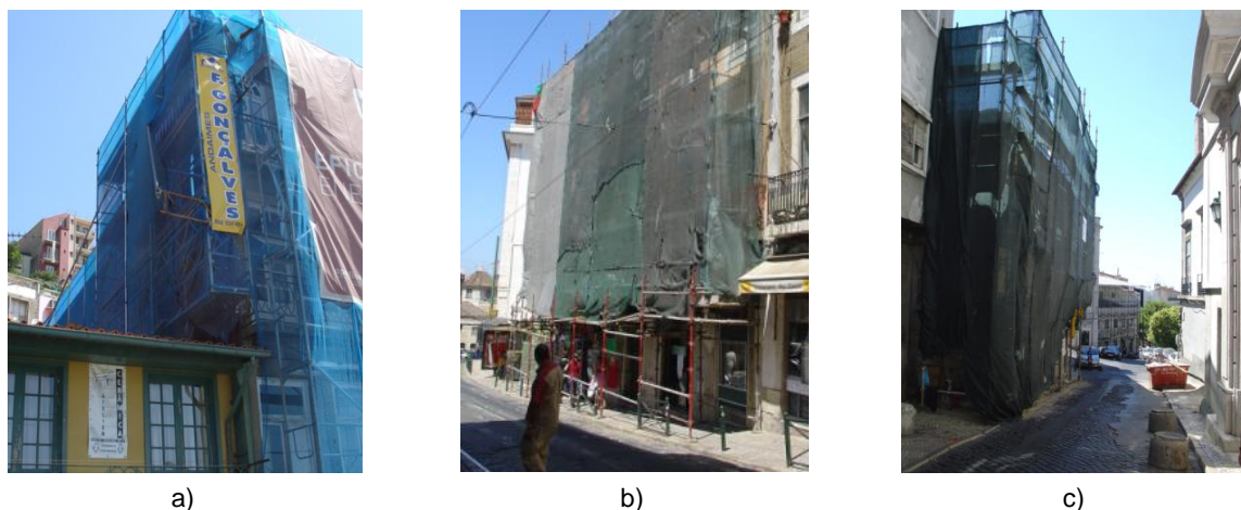
Figura 2.5 - a) Andaime sobre edifício adjacente; b) e c) Espaço de estaleiro reduzido com deposição de contentor para resíduos de construção e de demolição (RCD) em espaço público e ausência de stocks
