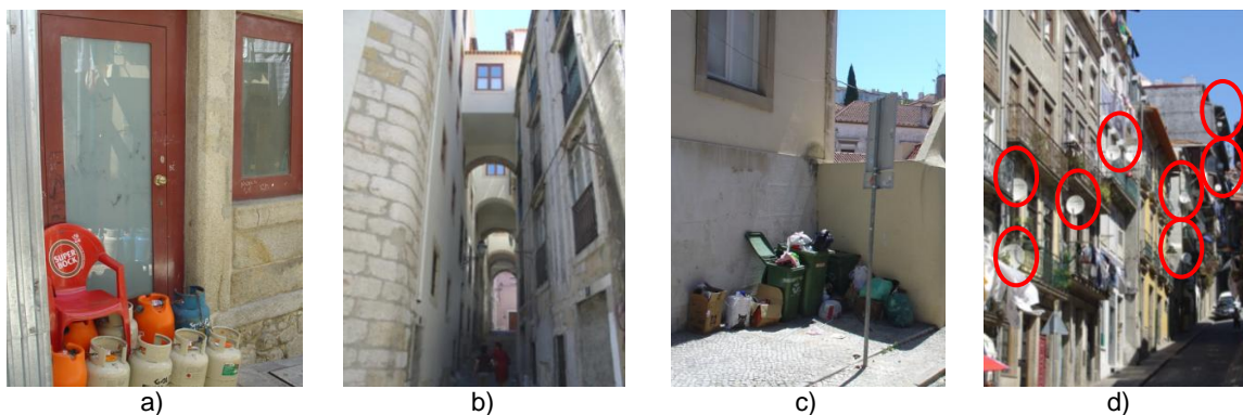
Figura 2.4 - a) Rua ocupada com diversos objetos; b) Proximidade entre vãos de edifícios; c) Espaços de contentores de RSU desajustado; d) Rua na zona histórica do Porto
