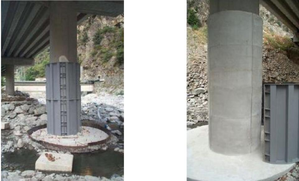
Figura 46 Reparação e proteção das fundações e dos pilares do viaduto The Valabres [57]
