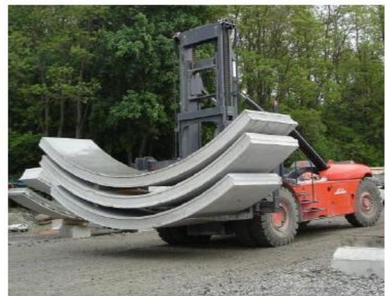
Figura 45 Transporte dos elementos pré-fabricados [56]
