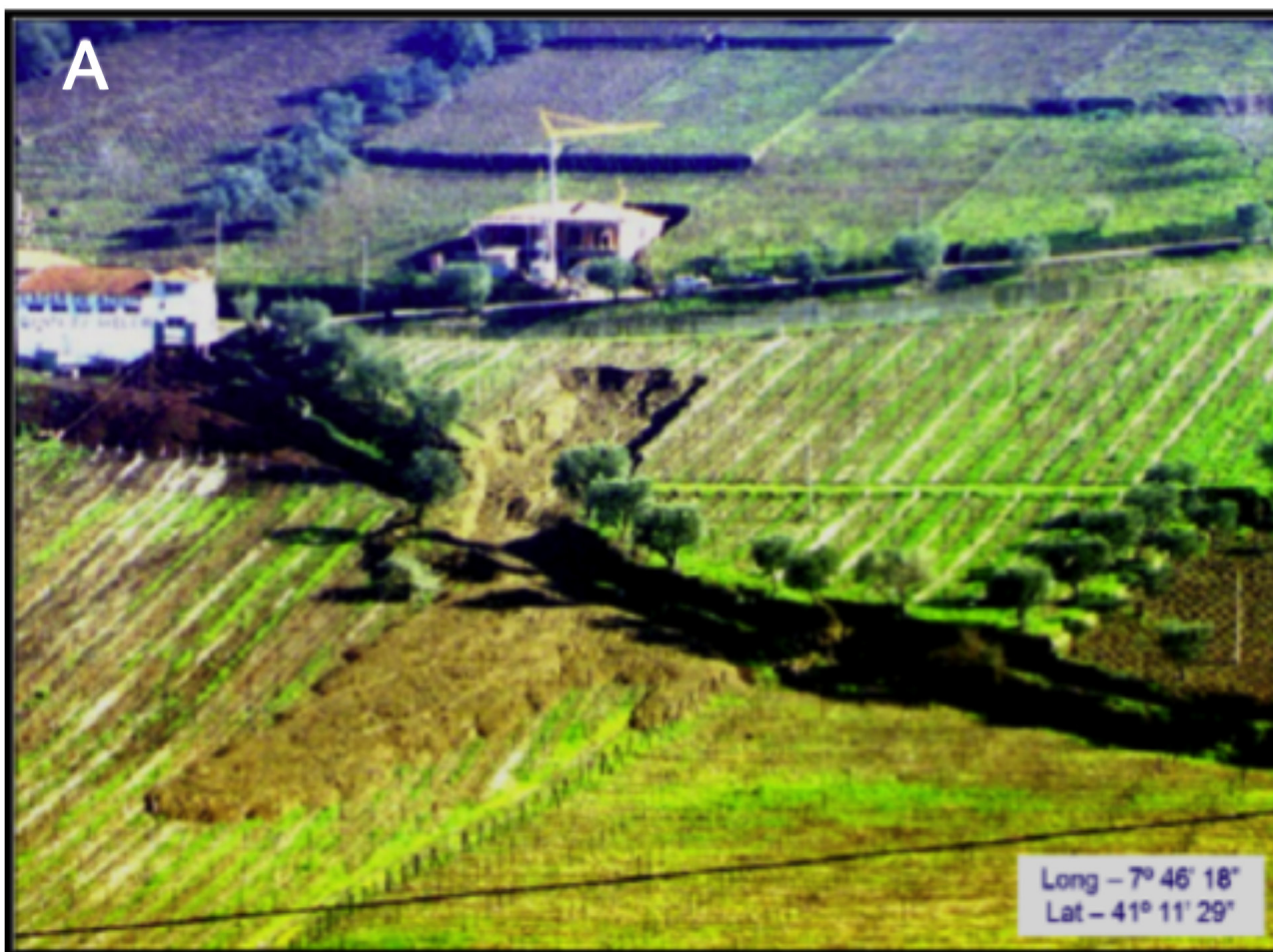
Figura 3 – Deslizamentos do vale Douro. A – fluxo de lama na “vinha ao alto”. B – deslizamento afetando muro (armação pós-floxera). C – reconstrução de muro com técnicas tradicionais
