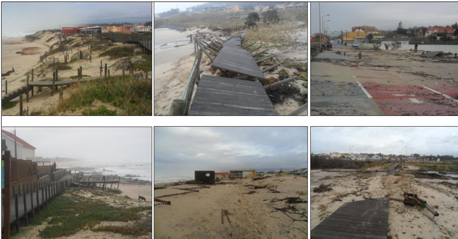
Figura 24: Fotografias da União das Freguesias de Gulpilhares e Valadares, após a tempestade “Hercules”.
