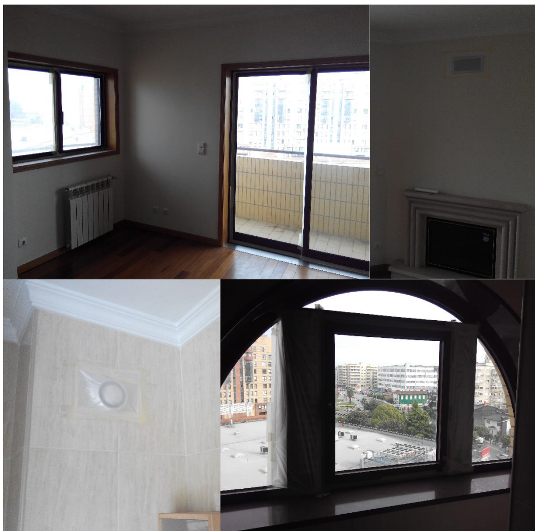
Figura 3.2- Exemplo de elementos do apartamento que provocam ventilação já selados.
