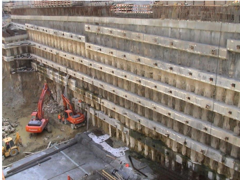
Figura 10 - Realização de ancoragens em cortinas de estacas – Estação Aliados (NSEENGINEERING,2011).
