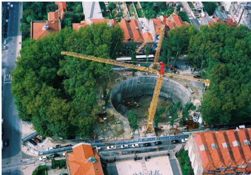
Figura 2 - Vista aérea da escavação do poço central da estação Marquês (Topa Gomes, 2008)
