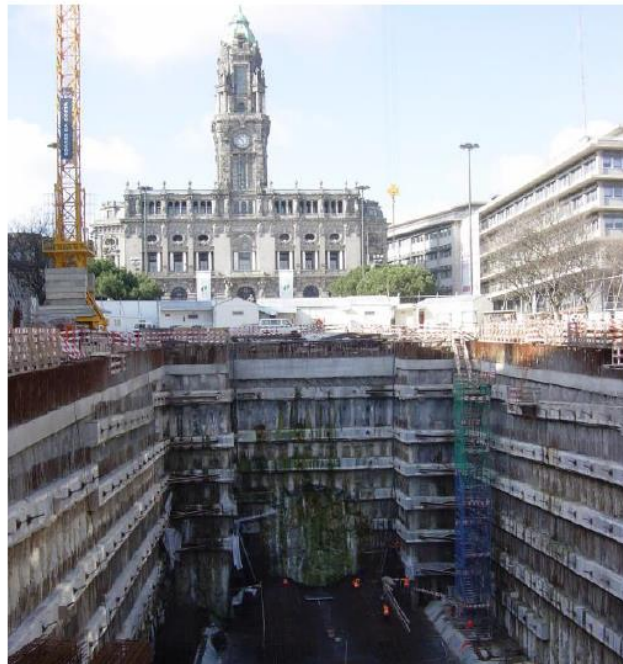
Figura 4 – Cortinas de Estacas Moldadas - Estação Aliados (Topa Gomes,2008).
