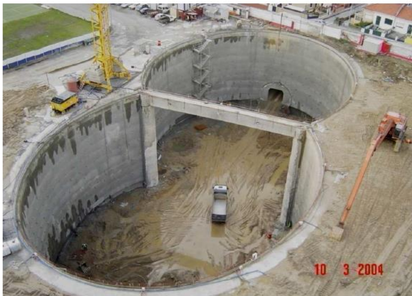
Figura 3 - Vista aérea da escavação de Salgueiros (Topa Gomes, 2008)
