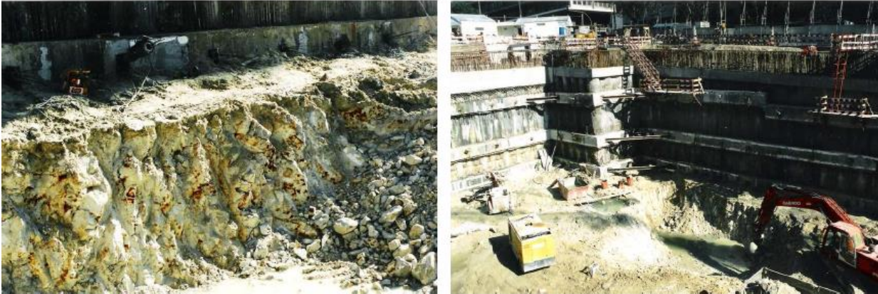
Figura 26 - Sobre escavação à cota 56,50 m, (fotografias de Viana da Fonseca, 2003).
