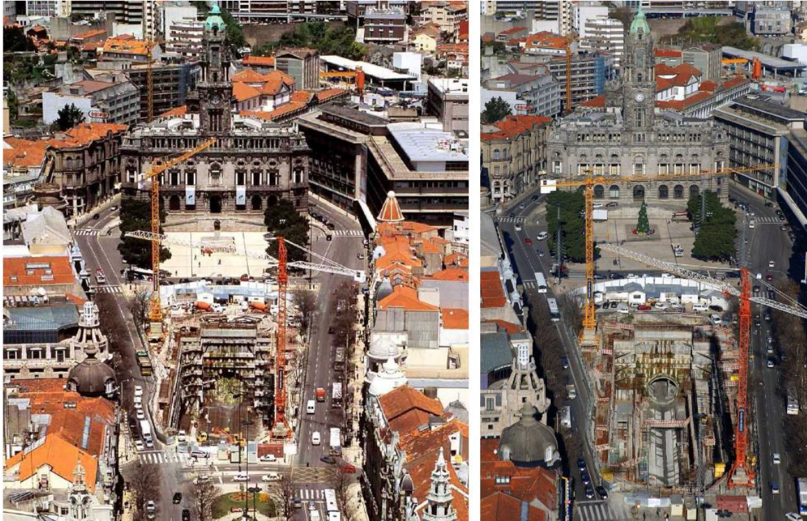
Figura 29 - Zona de implantação da estação Aliados (F. Piqueiro/Foto Engenho, Lda, 2003).
