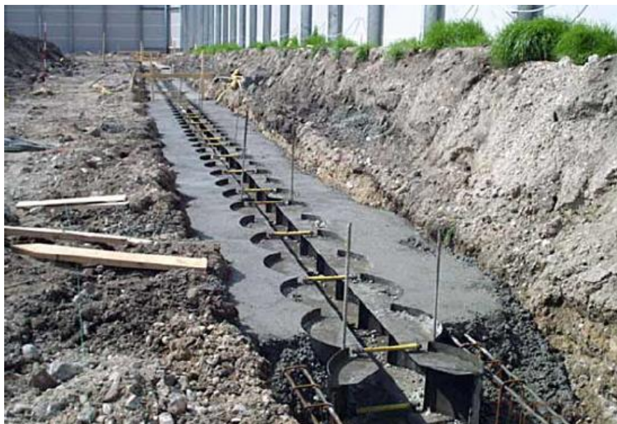
Figura 9 - Execução de muros-guia (Meireles, 2006).
