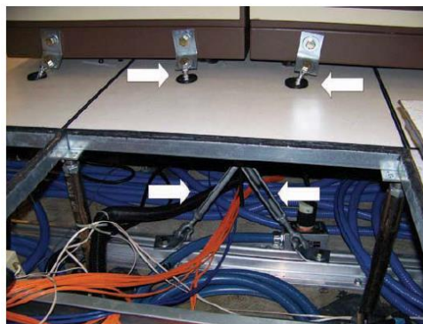
Fig.5.14. – Fixação através de parafusos de esticamento [21]
