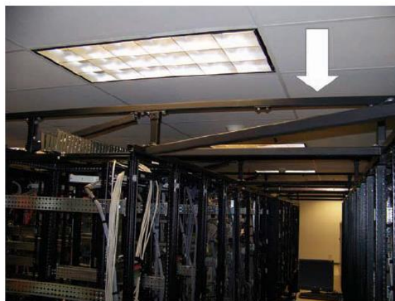
Fig.5.15. – Fixação dos equipamentos através de uma estrutura auxiliar [21]
