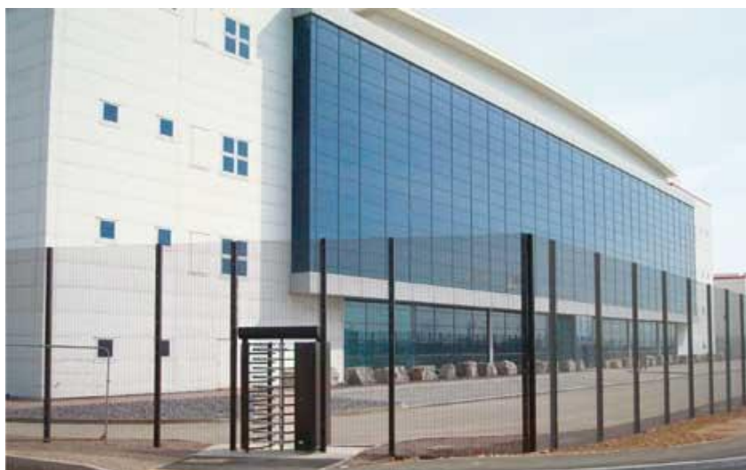
Fig.4.9. – Vista exterior do data centre NGD, Terremark, Reino unido [w18]
