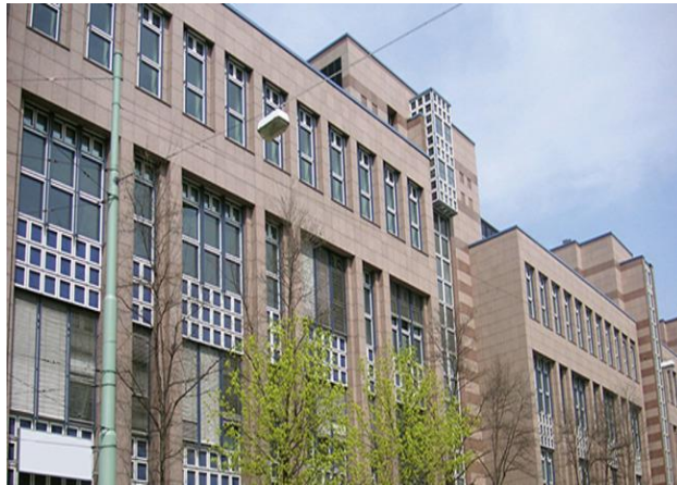
Fig.4.10. – Vista exterior do data centre Equinix mu1 IBX, Alemanha [w22]
