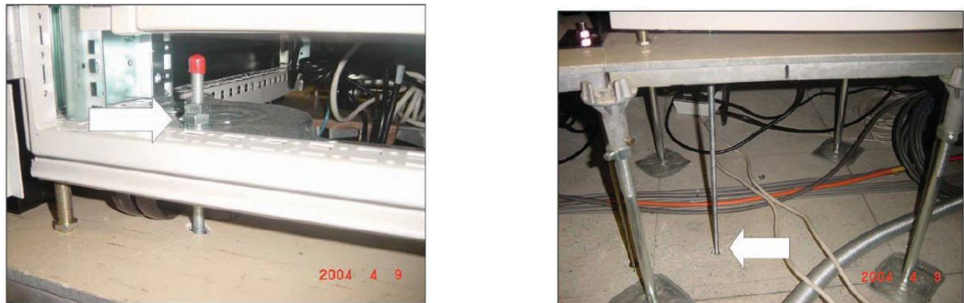
Fig.5.13. – Fixação dos equipamentos através de parafusos verticais [21]
