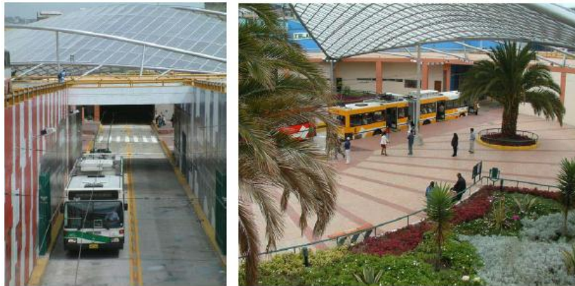
Fig.32 – Passagem subterrânea, Quito. (Lloyd Wright, 2008)
