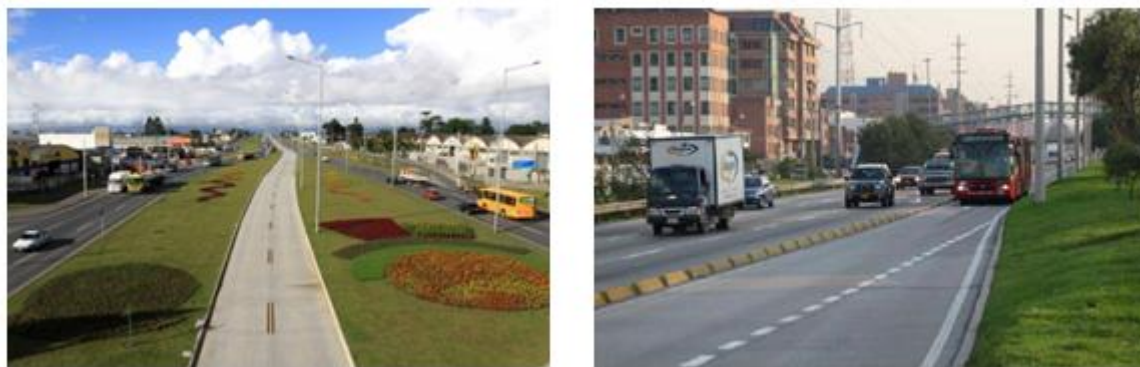
Fig. 8a) e 8b) – Faixas exclusivas para BRT, Curitiba e Bogotá. (Ministério das Cidade, 2008).
