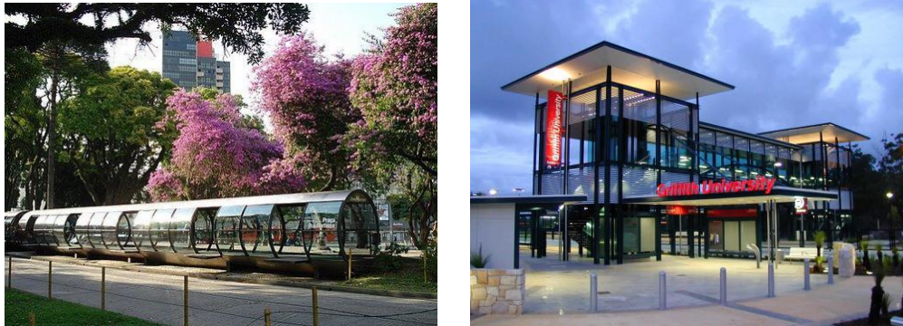
Fig. 10a) e 10b) – Estação “tubo”, Curitiba e estação Griffith University de Brisbane, Austrália. (ITDP,2012)
