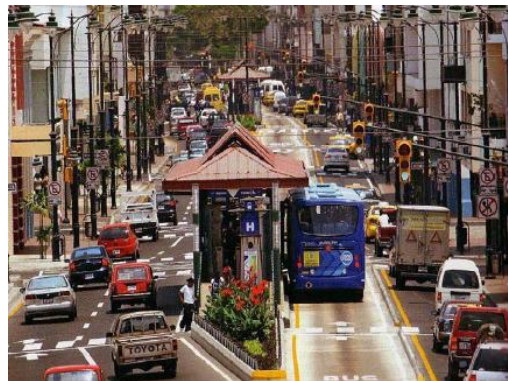
Fig.30 – Corredor dividido nas áreas centrais da cidade, sistema Metrovía de Guayaquil. (Manual BRT,2008)
