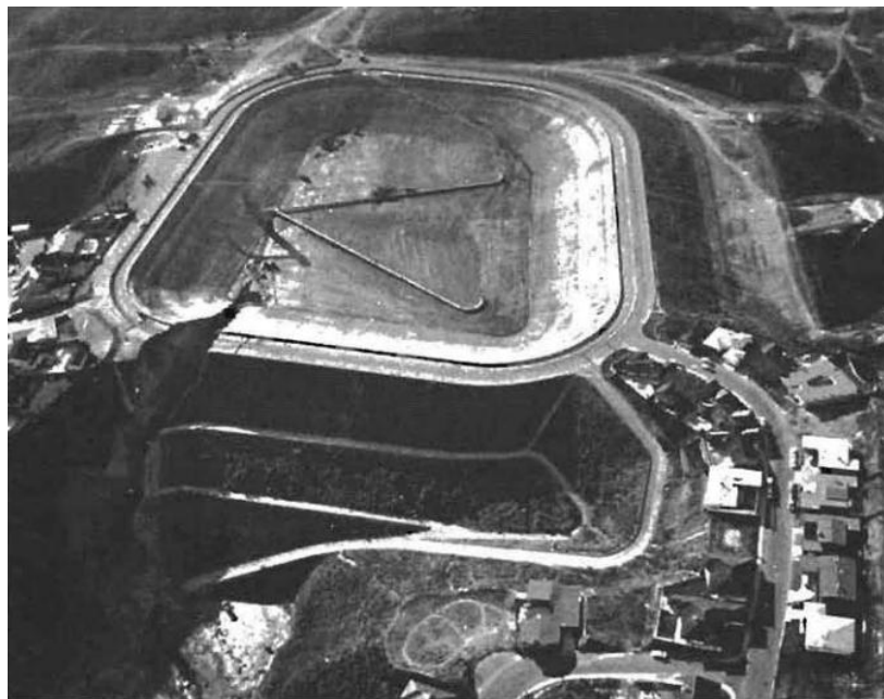
Figura 3.79 – Reservatório de Baldwin Hills depois da rutura (retirado de [58])
