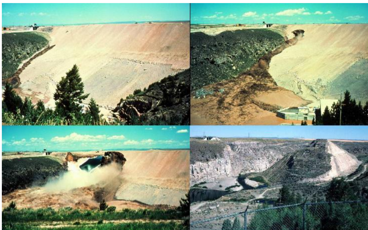
Figura 3.80 – Evolução, numa série de fotos, da rutura da barragem de Teton (EUA) e uma foto do local após o desastre (adaptado de [56])
