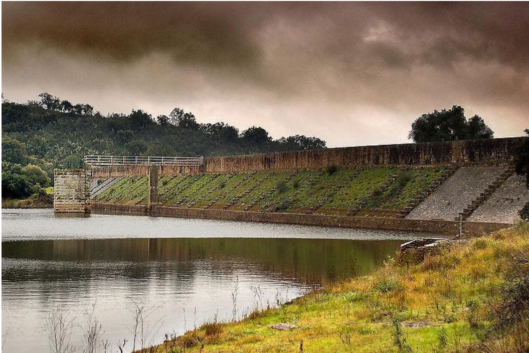
Figura 2.1 – Barragem Romana de Cornalvo (Espanha,séc. I) (retirado de [2])
