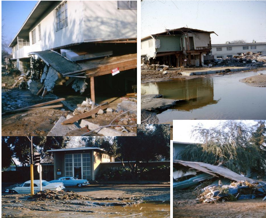
Figura 3.78 – Alguns dos danos causados devido ao acidente em Baldwin Hills (adaptado de [57])
