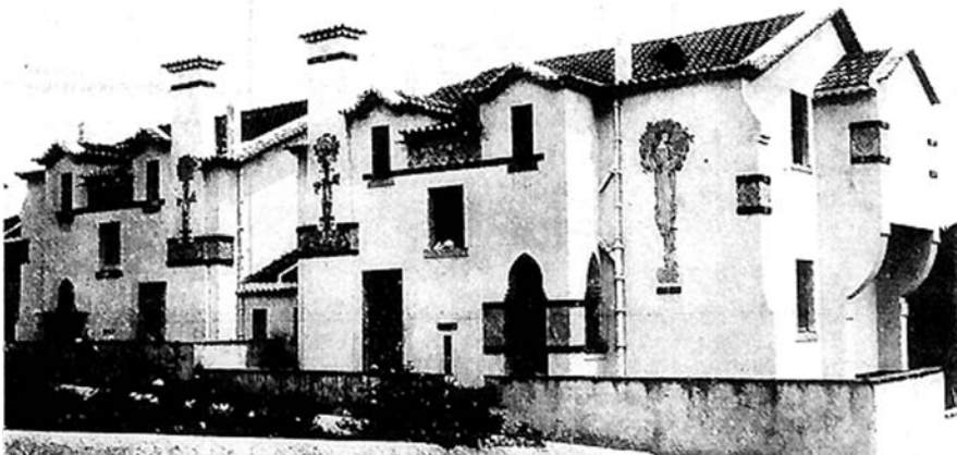
Casas Álvaro Machado, fachada principal, Álvaro Machado, 1910
