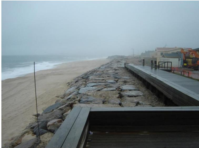
Figura 2 – Estrutura aderente no Mindelo, já na fase final da construção
