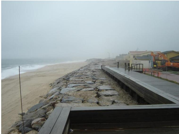
Figura 11 – Estrutura aderente no Mindelo na fase final da construção
