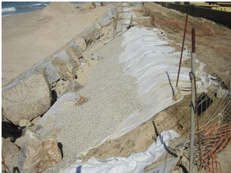
Figura 9 – Estrutura aderente da praia de Mindelo em fase intermédia de construção
