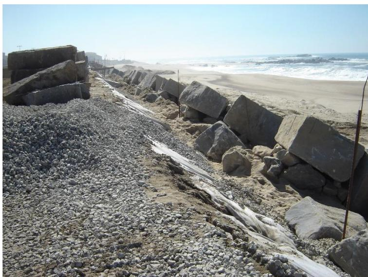
Figura 10 – Estrutura aderente no Mindelo na fase intermédia de construção (continuação)
