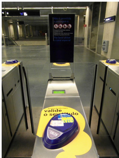
Fig. 4.9 – Sistema de bilhética e controlo de acessos numa estação do Metro de Lisboa (Fonte: ideiasdomeuporto.com)
