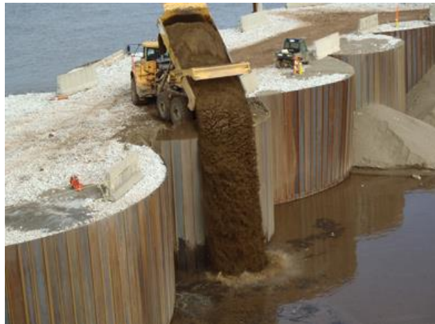
Fig. 2. 2 - Exemplo de ensecadeira de células com berma em processo de construção [11]
