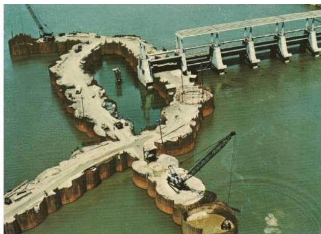
Fig. 2. 8 - Preenchimento de uma célula recorrendo a maquinaria de dragagem com garras [16]
