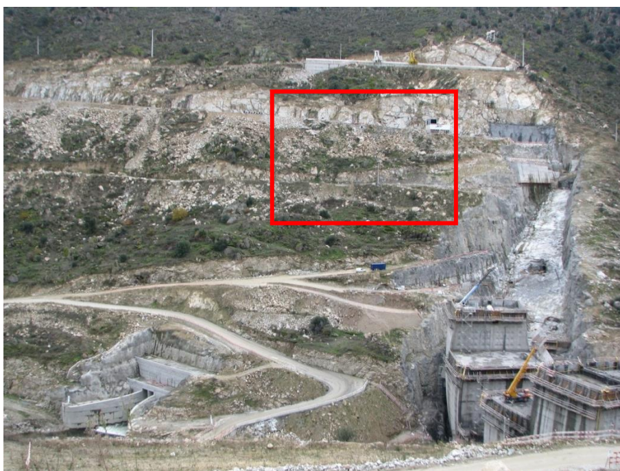
Fig. 4. 4 - Local previsto para a implantação da ensecadeira - Margem esquerda [29]
