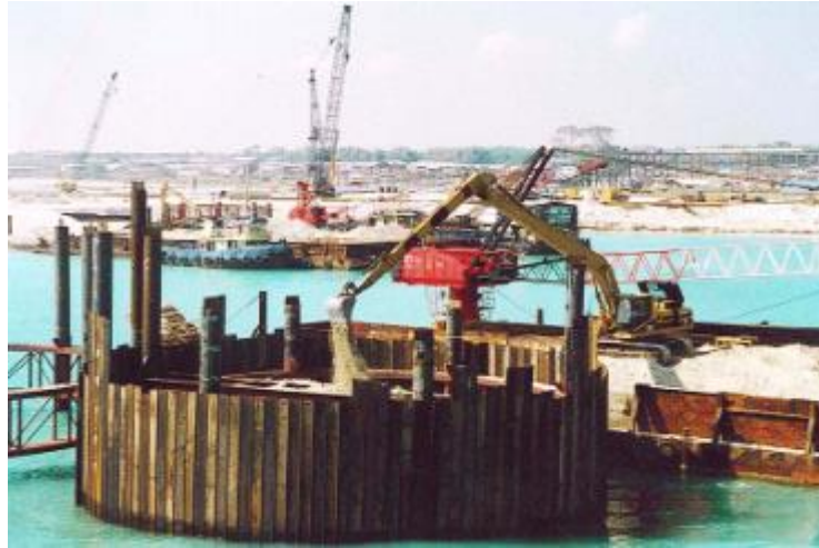
Fig. 2. 9 - Colocação do material seco numa célula [17]
