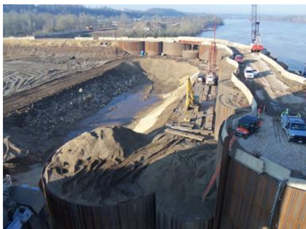
Fig. 2. 11 - Construção de uma berma interior [11]
