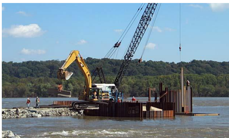
Fig. 2. 15 - Operação de posicionamento e cravação de estacas prancha [19]
