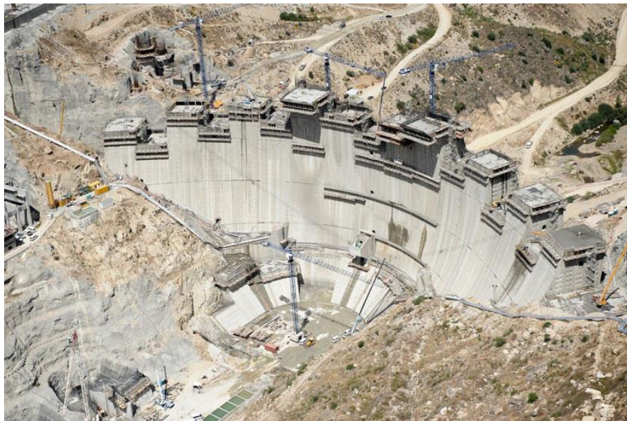
Fig. 4. 1 - Barragem de montante do Baixo Sabor [30]
