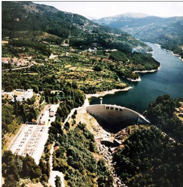
Fig. 5. 1 - Vista geral da barragem da Caniçada [34]
