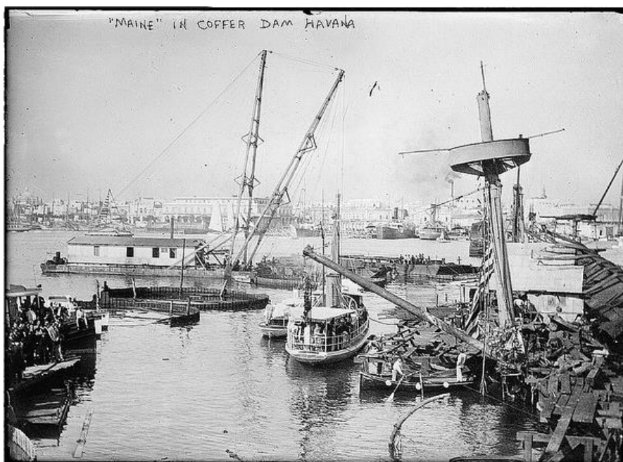
Fig. 1. 5 - Ensecadeira construída para a remoção do navio militar USS Maine [7]
