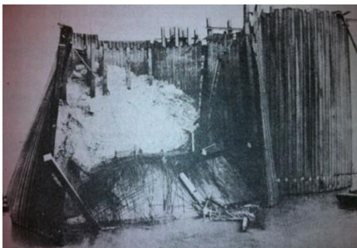
Fig. 2. 17 - Célula número 13 após rotura [6]
