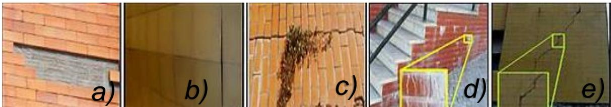
Fig. 53 – Representação de anomalias em revestimentos cerâmicos: a) Destacamento dos ladrilhos. (Silvestre, 2005). b) Empolamento dos ladrilhos. (Silvestre, 2005) c) Colonização biológica (Silvestre, 2005). d) Eflorescências. (Sousa, 2008). e) Fissuração. (Silvestre, 2005)
