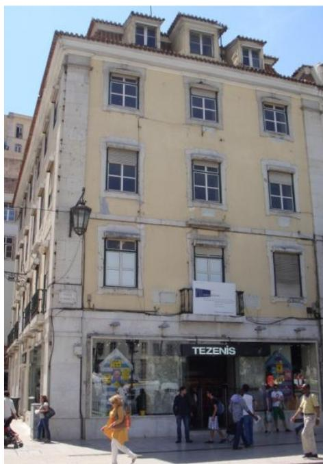
Fig. 37 – Eliminação de elementos estruturais para abertura de montra (Roseiro, 2012)
