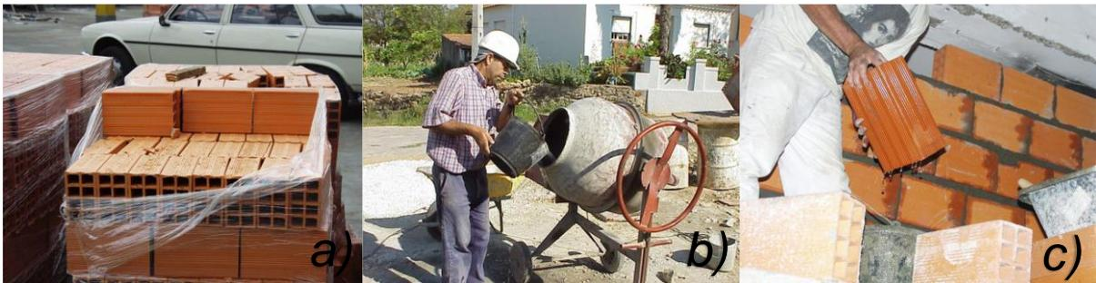
Fig. 43 – a) Materiais não totalmente protegidos da chuva no estaleiro. b) Água introduzida nas paredes através do excesso de água nas argamassas. c) Molhagem excessiva do tijolo, na fase de assentamento, a evitar com a adoção de retentores de água nas argamassas. (Silva, 2009)
