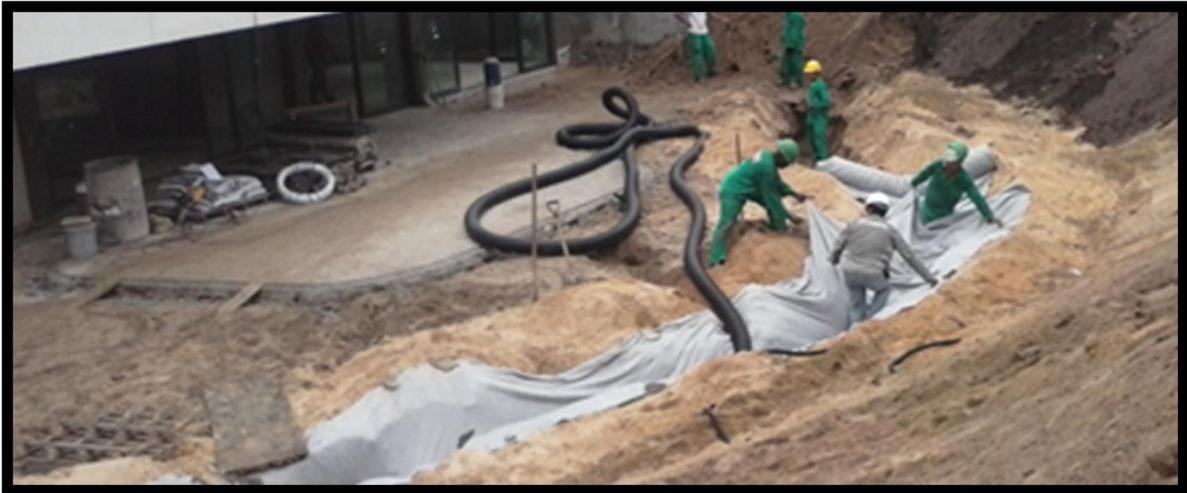
Fig. 16 – Execução do dreno horizontal (Póvoas, Gomes 2015)
