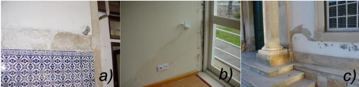
Fig. 44 – a) Parede sujeita a fenómeno de humidade ascensional agravado pela impermeabilização parcial da face interior, com material cerâmico. b) Humidade ascensional em edifício de construção recente, proveniente de águas superficiais exteriores infiltradas através de deficiente desempenho da soleira. c) Humidade ascensional em edifício histórico, agravada pela existência de degrau exterior com inclinação para o lado da parede e não para o exterior. (Silva, 2009)
