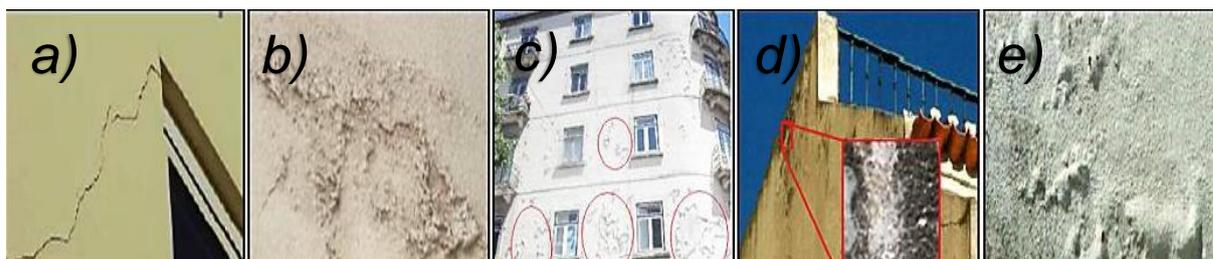
Fig. 52 – Representação de anomalias em revestimentos de pintura: a) Fissuração. (Chaves, 2009). b) Criptoflorescência (Chai, 2011). c) Destacamento (Chai, 2011). d) Colonização biológica. (Chai, 2011). e) Empolamento (Chai, 2011).
