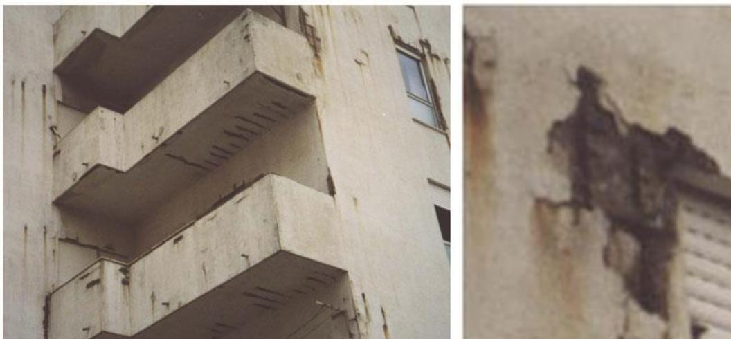
Fig. 40 – Fachada de um edifício localizado junto ao mar – Corrosão das Armaduras (PATORREB, 2016)
