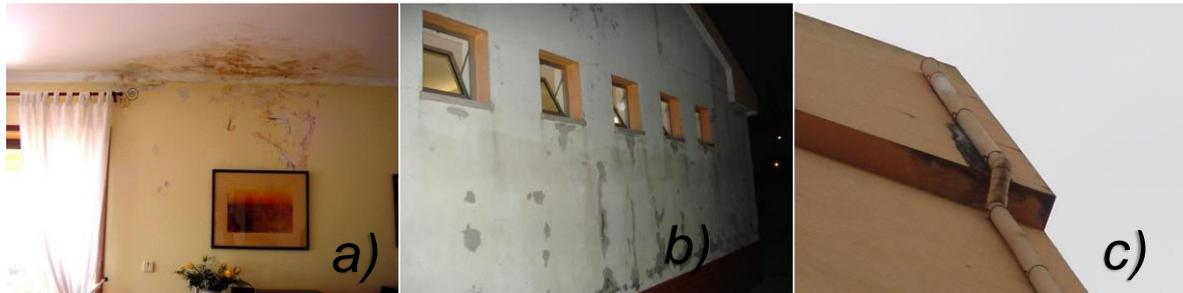
Fig. 49 – a) Infiltração localizada e fortuita, por acidente na vedação/estanquidade de tubo de queda. b) Infiltrações (de dentro para fora) em bateria de balneários desportivos com rotura de canalizações ou acessórios não estanques. c) Infiltração pontual e fortuita por deficiência da fixação do tipo de queda à parede.
