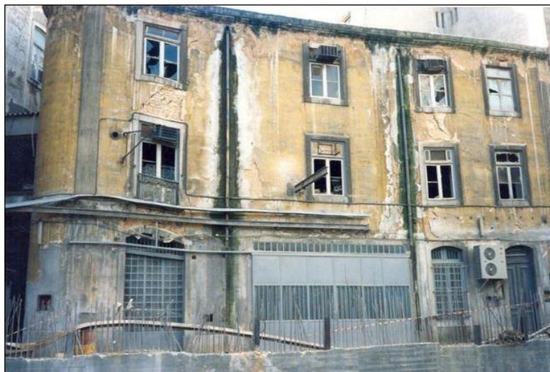
Fig. 36 – Deformação resultante de movimentos de terras (Roseiro, 2012)
