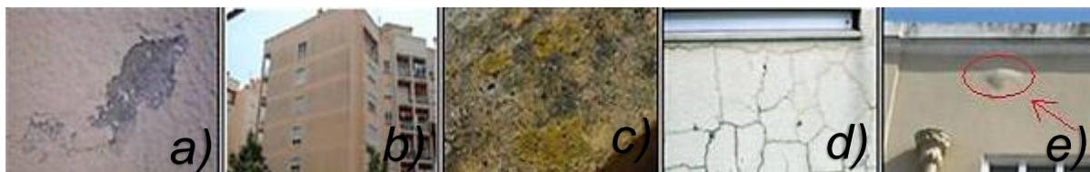
Fig. 51 – Representação de algumas anomalias correntes em rebocos: a) Criptoflorescência. (Flores-Colen, 2012). b) “Fantasmas” (Flores-Colen, 2012). c) Formação biológica – Líquenes (Flores-Colen, 2012). d) Fissuração mapeada (Flores-Colen, 2012). e) Deformação ou empolamento (Flores-Colen, 2012).
